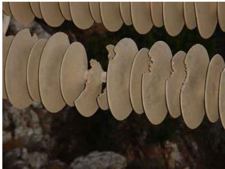
Σχήμα 1.18: Συνθετικοί μονωτήρες έπειτα από επίθεση μεγάλων πτηνών σε γραμμή 150 kV του συστήματος μεταφοράς της Κρήτης [33].
