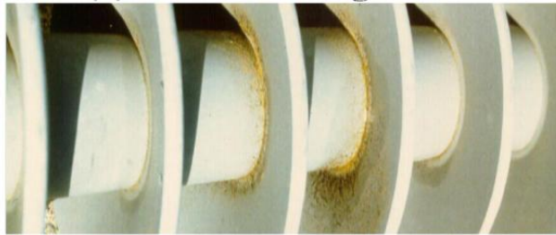
Σχήμα 1.26: Αλλοίωση στη διεπιφάνεια μεταξύ δίσκου και περιβλήματος του μονωτήρα [39].
