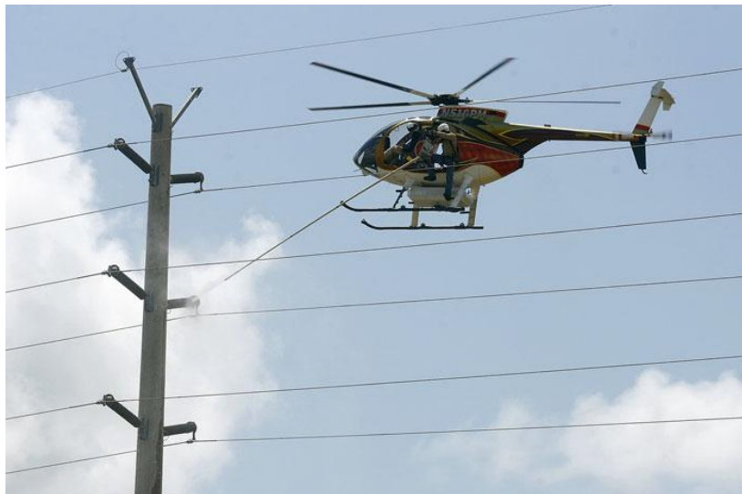
Σχήμα 1.15: Πλύσιμο κεραμικών μονωτήρων με ελικόπτερο [35].
