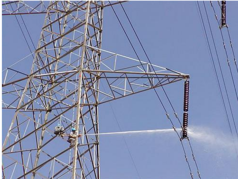
Σχήμα 1.14: Τεχνίτες αναρριχώνται πάνω στον πυλώνα για πλύσιμο κεραμικών μονωτήρων [34].
