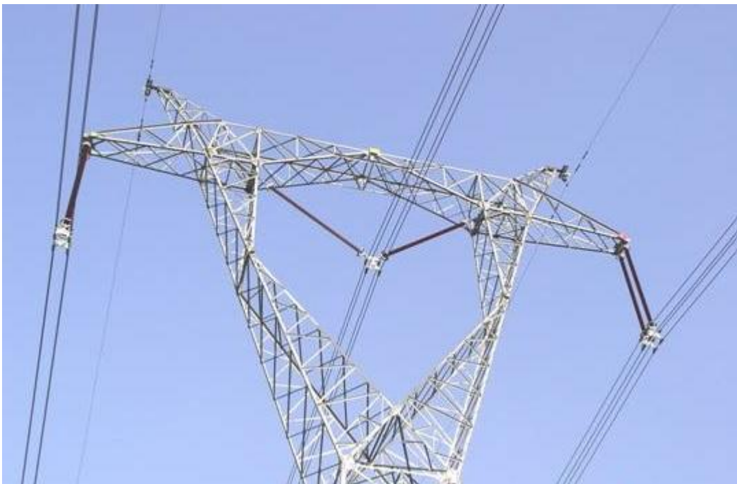
Σχήμα 5.1: Τμήμα πυλώνα όπου συνυπάρχουν διαφορετικών ειδών διατάξεις μονωτήρων [58].
