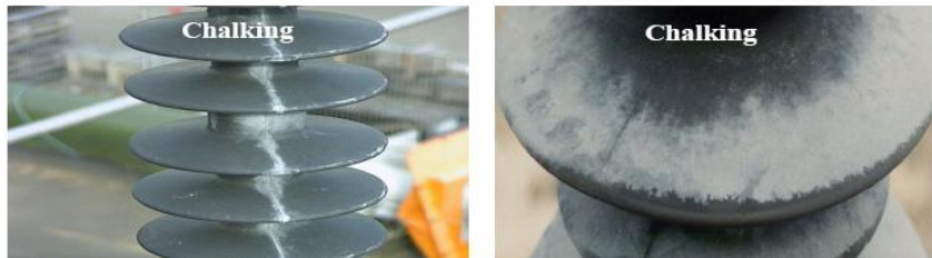
Σχήμα 1.22: Αλλοίωση στην περιοχή των δίσκων του μονωτήρα [39].
