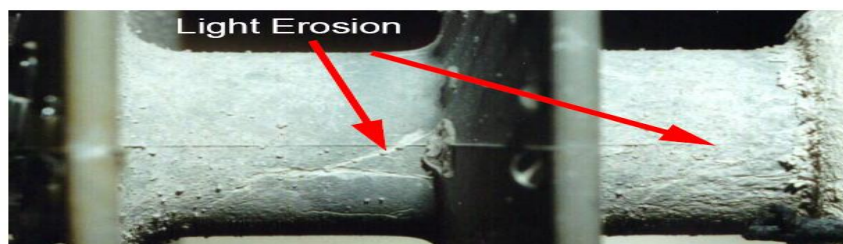
Σχήμα 1.27: Αλλοίωση στο περίβλημα/άτρακτο του μονωτήρα [39].
