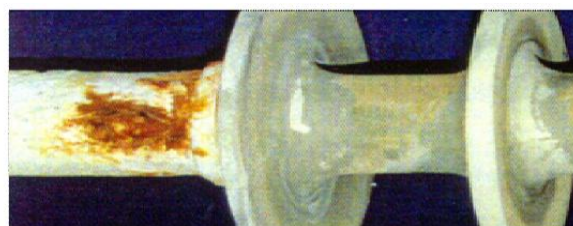
Σχήμα 1.25: Αλλοίωση στην περιοχή του μεταλλικού άκρου του μονωτήρα [39].
