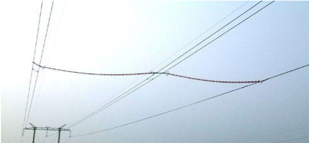
Σχήμα 1.8: Συνθετικοί μονωτήρες ως διαχωριστές φάσεων [23].
