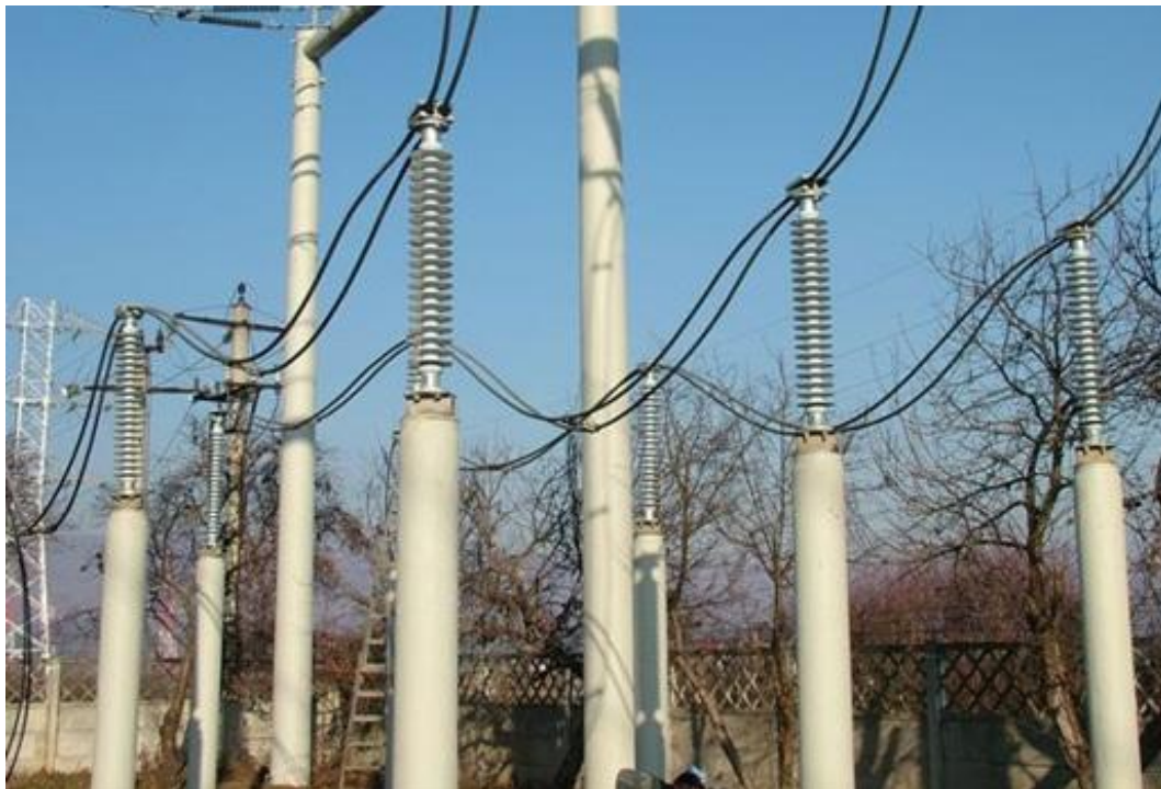
Σχήμα 1.7: Συνθετικοί μονωτήρες στήριξης σε Υποσταθμό Υψηλής Τάσης [22].
