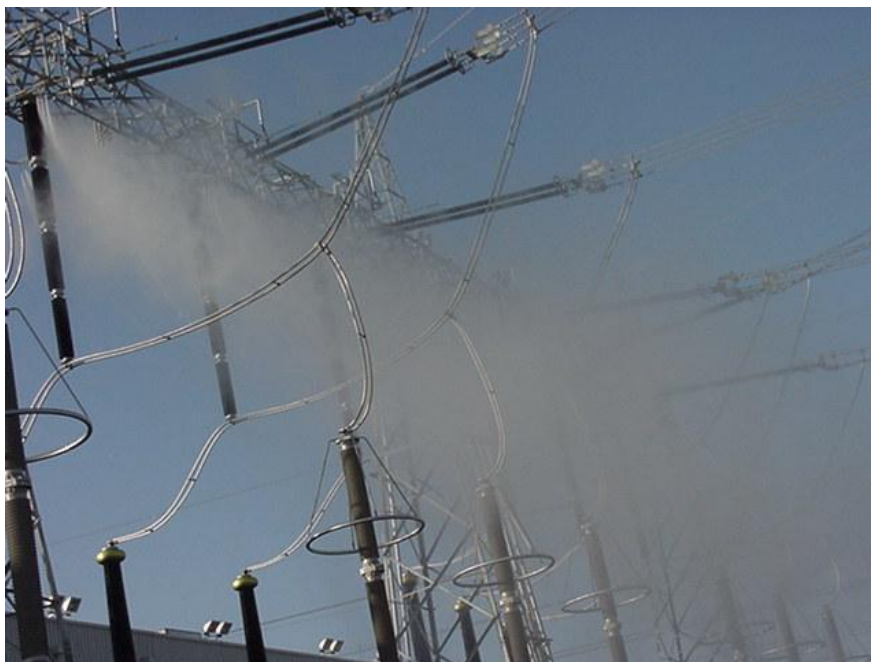
Σχήμα 1.16: Πλύσιμο κεραμικών μονωτήρων σε Υποσταθμό με ενσωματωμένο σύστημα πλύσης [36].
