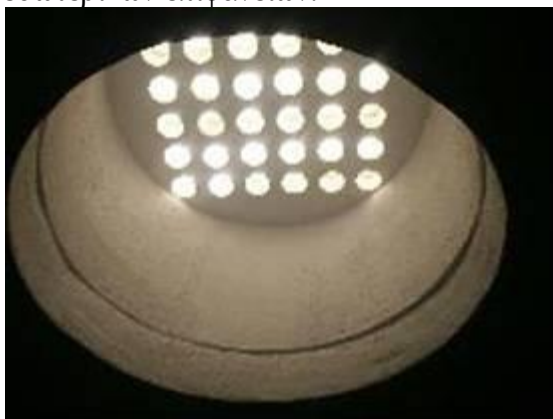
Εικόνα 2.4: Είσοδος φυσικού φωτισμού από θόλο. Πηγή: ΚΑΠΕ
