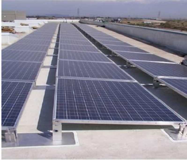
Εικόνα 3.1: Παράδειγμα εγκατάστασης φβ σε ταράτσα. Πηγή ΣΕΦ
