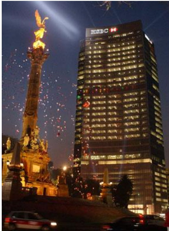
Εικόνα 3.11: Φωτισμένος πύργος. Πηγή: http://www.lighting.philips.gr/projects/hsbc_tower
