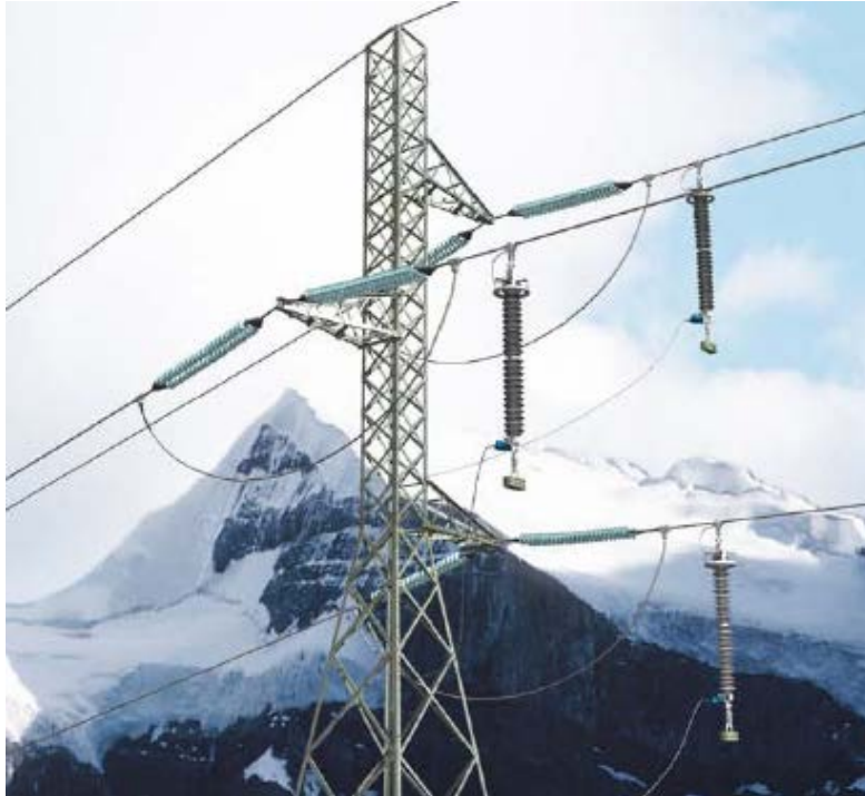
Εικόνα 1.13: Γραμμή μεταφοράς εφοδιασμένη με αλεξικέραυνα
