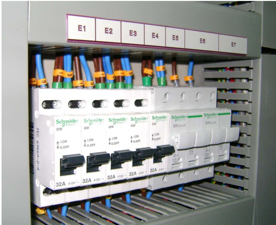
Εικόνα 2.7: Διπολική αποξέυκτη ηλεκτρονόμων και υπολογιστών πίνακα και ασφάλειες στην πλευρά AC των ανορθωτών
