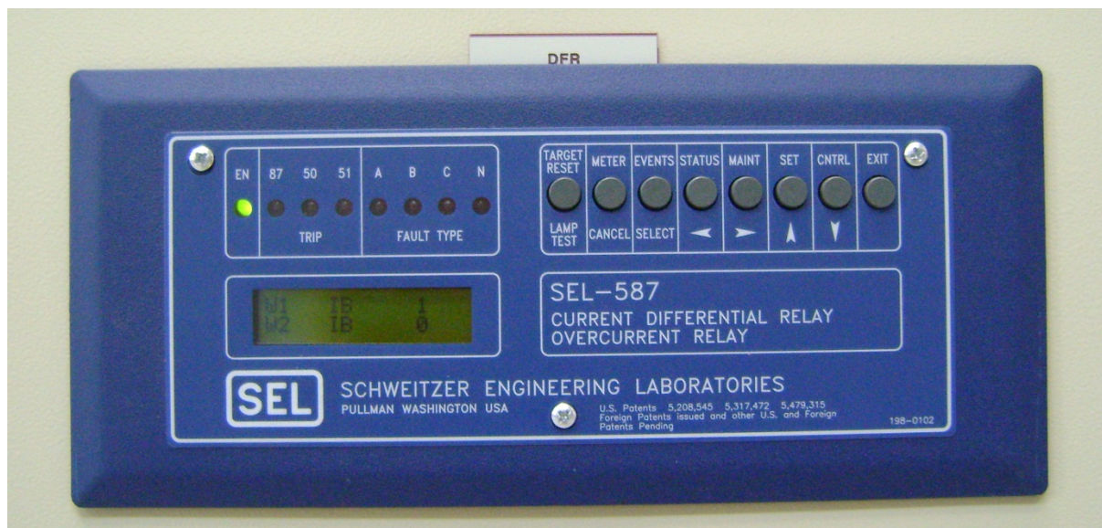
Εικόνα 2.54: Πρόσθια όψη ηλεκτρονόμου SEL-587
