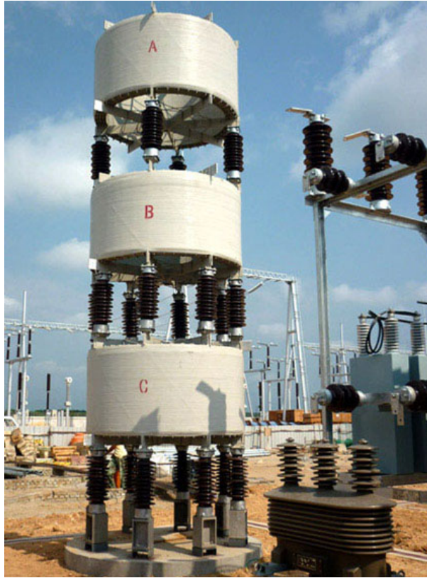
Εικόνα 1.8: Πηνία αέρος για εφαρμογή σε σειρά ή παράλληλα
