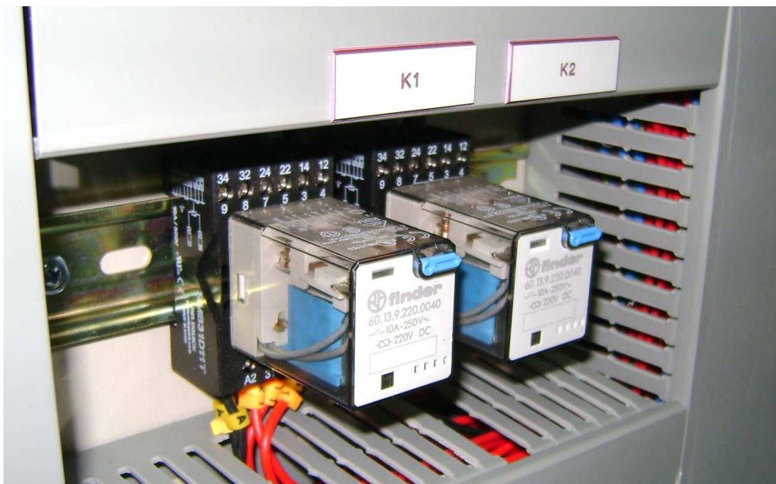
Εικόνα 2.8: Ηλεκτρονόμοι K1, K2
