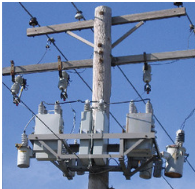
Εικόνα 1.11: Συστοιχία πυκνωτών σε εναέρια γραμμή MT (Pole-mounted capacitor bank)
