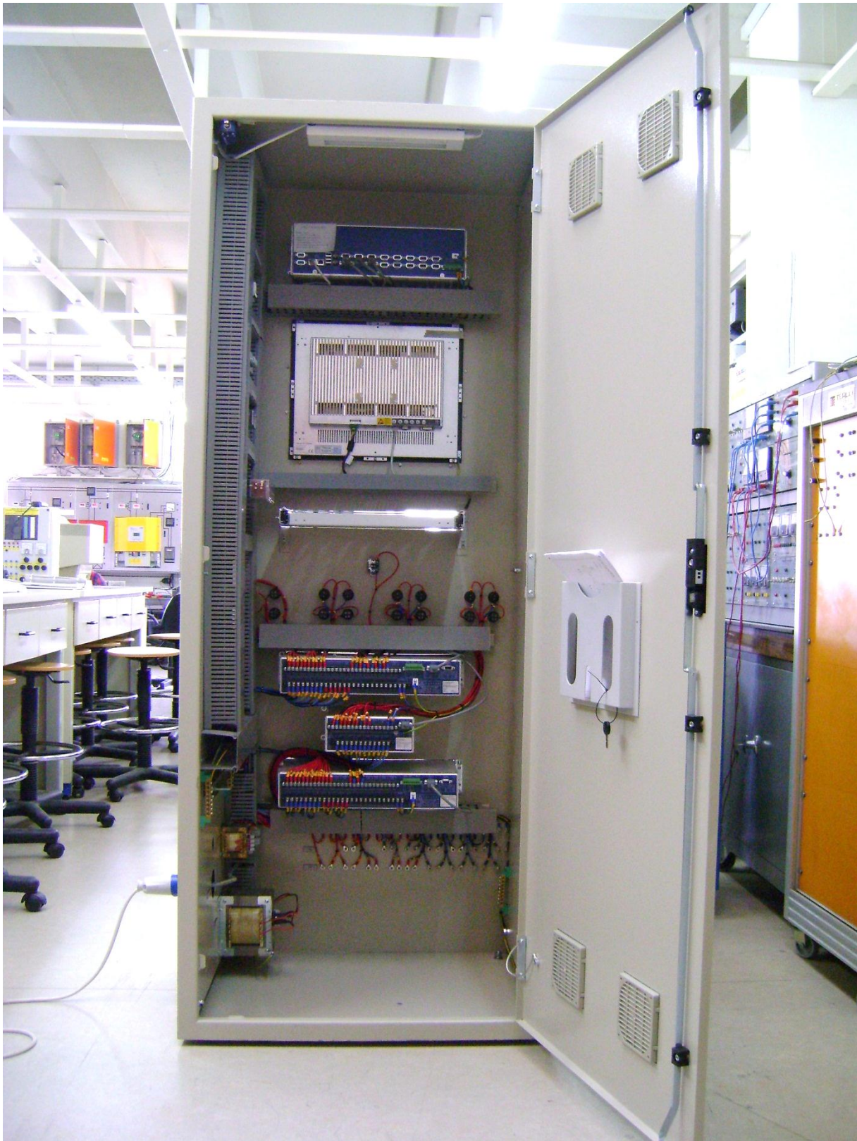
Εικόνα 2.4: Οπίσθια όψη εργαστηριακού συστήματος προστασίας
