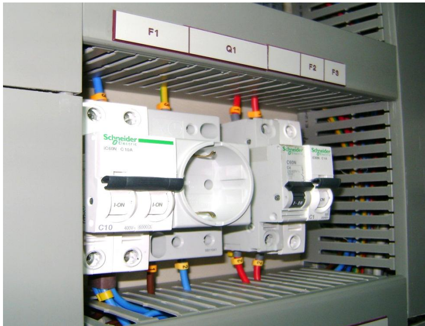
Εικόνα 2.6: Γενικός διπολικός μικροαυτόματος διακόπτης πίνακα και μονοπολικό μικροαυτόματο διακόπτες στην πλευρά DC των ανορθωτών
