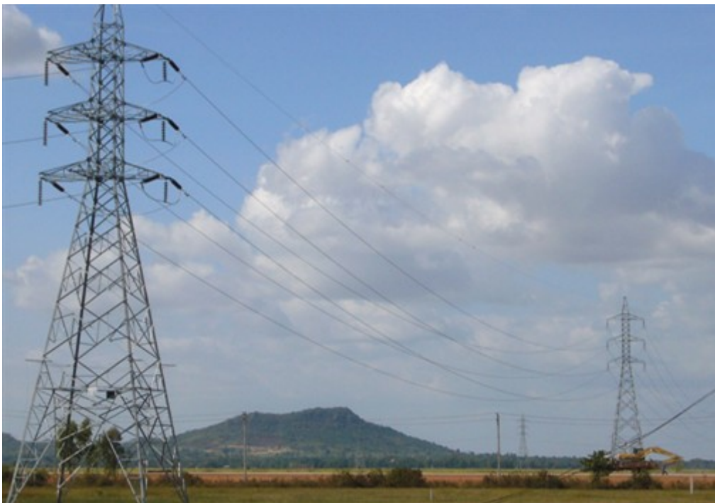
Εικόνα 1.5: Γραμμή μεταφοράς διπλού κυκλώματος 115 KV
