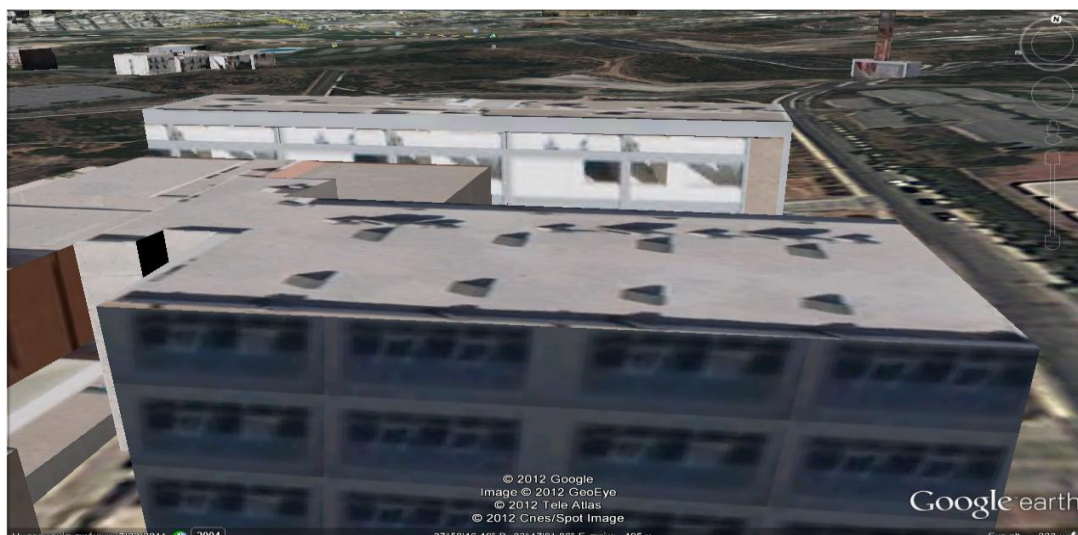
Εικόνα 7.3 : Το υπό μελέτη κτίριο του τμήματος HMMY του ΕΜΠ όπως φαίνεται από το νότο.
