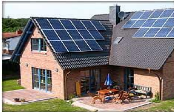
Εικόνα 4.12: Φωτοβολταϊκά ενσωματωμένα σε κτίρια
