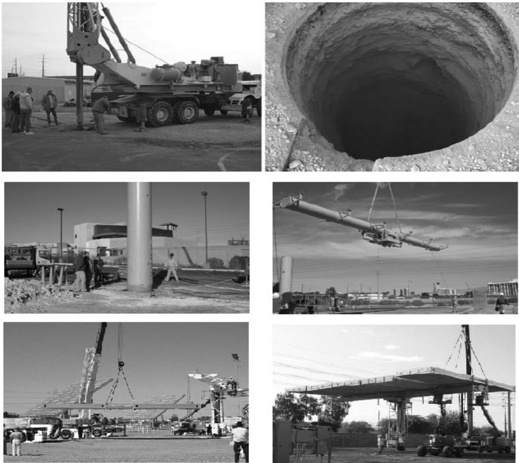
Εικ. 4.7. Εγκατάσταση συστήματος HCPV
