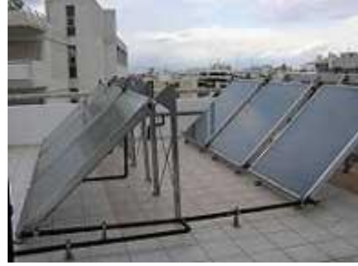
Σε οριζόντια στέγη
