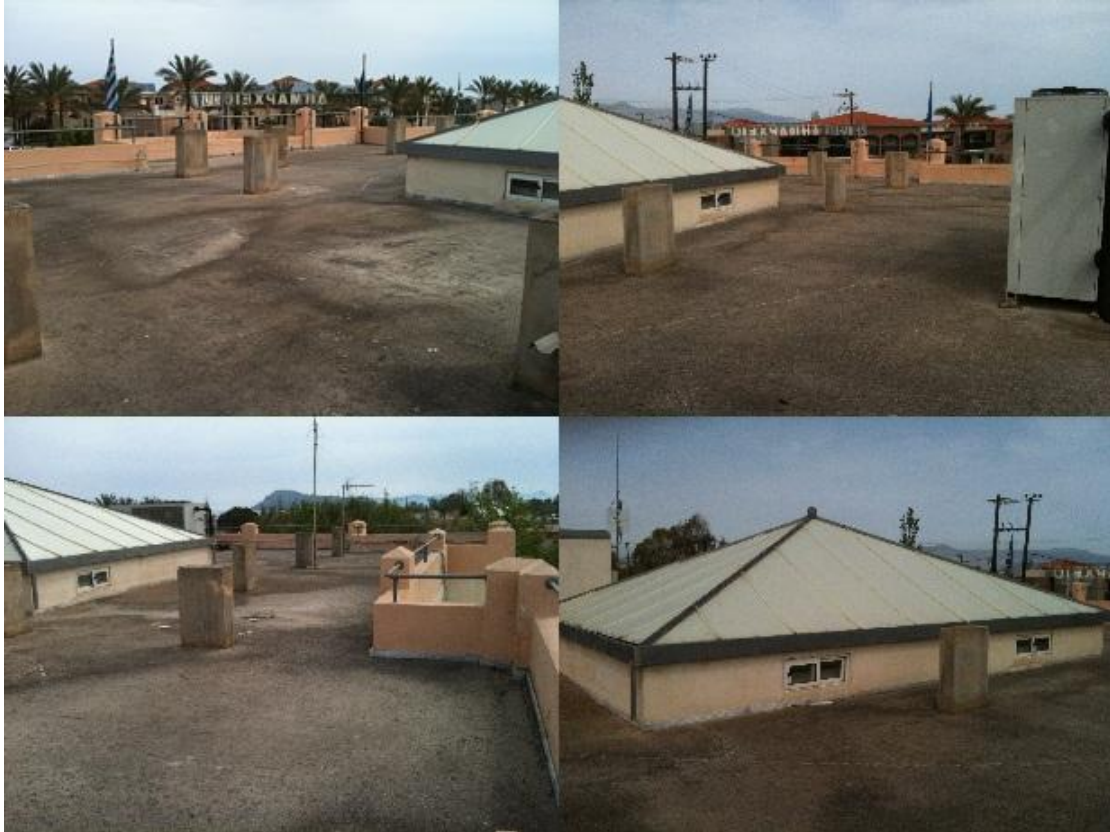
Σχήμα 5.9 Φωτογραφίες και από τις 4 πλευρές της οροφής του κτιρίου
