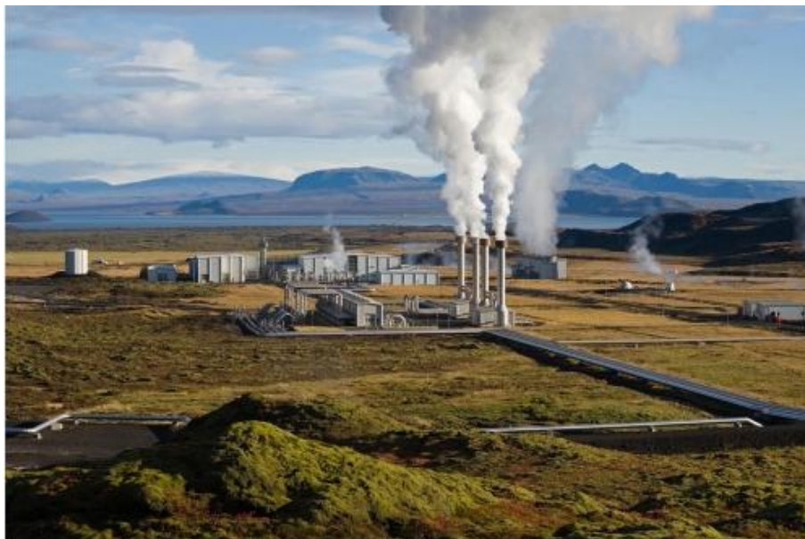
Εικόνα 1.1 Ο σταθμός παραγωγής Nesjavellir στην Ισλανδία είναι ένα τυπικό παράδειγμα συστήματος ξηρού ατμού.[7]
