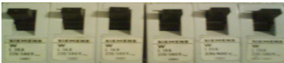
Εικόνα 9: Ασφάλειες με διμεταλλικό έλασμα (Εφαρμογή σε οικιακή εγκατάσταση)
