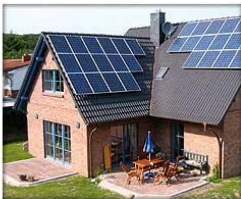
Σχ. 2.15: Φωτοβολταϊκά ενσωματωμένα σε κτίρια
