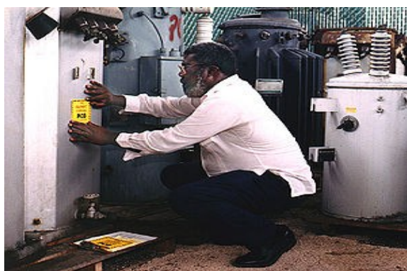
Σχ. 4.3 Απόσυρση μετασχηματιστών με PCB και η σχετική ετικέτα
