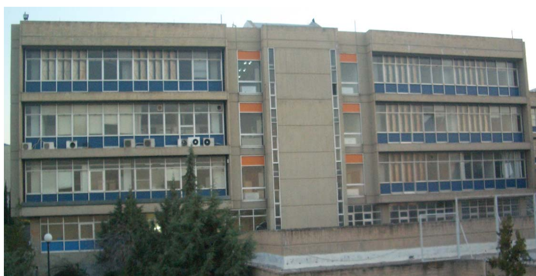
Σχήμα 4. 5 : Ψηφιακή εικόνα όψης του κτιρίου Α.
