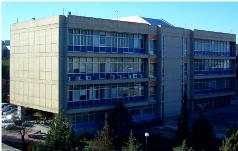
Σχήμα 3.4 : Εξωτερική Όψη Κτιρίου Α
