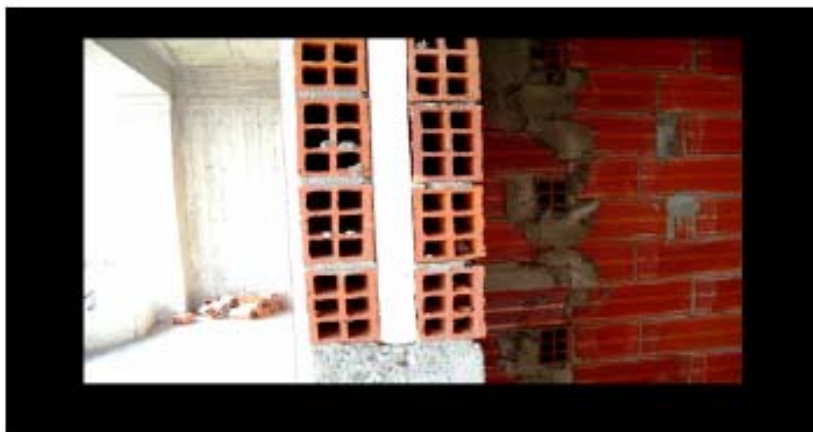
Σχήμα 2. 7 : Τομή θερμομόνωσης τύπου σάντουιτς
