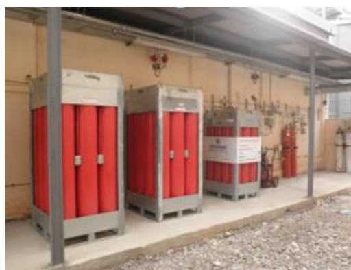
Εικόνα 2.4. Συσκευή ηλεκτρόλυσης ErreDue G6AP για την παραγωγή υδρογόνου και σύστημα απόθηκευσης και διανομής του.
