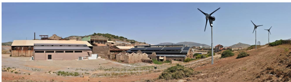
Εικόνα 2.1. Πανοραμική εικόνα του χώρου εφαρμογής του ερευνητικού προγράμματος H 2 SusBuild στο Τεχνολογικό και Πολιτιστικό Πάρκο Λαυρίου.
