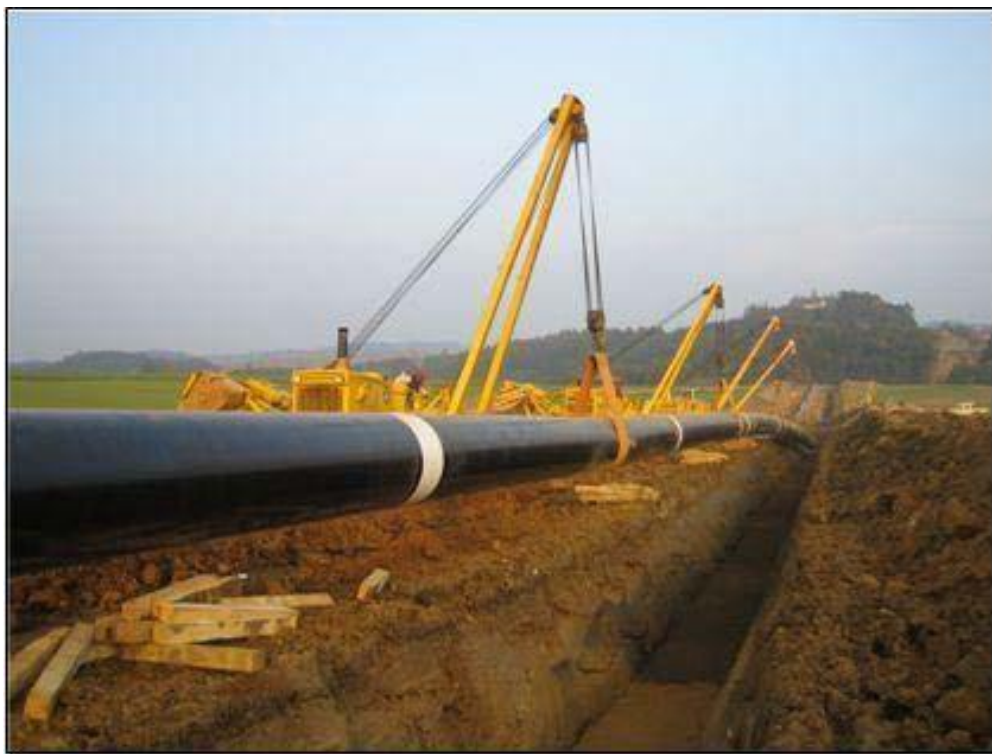
Εικόνα 2.17: Τοποθέτηση αγωγού Υ.Π
