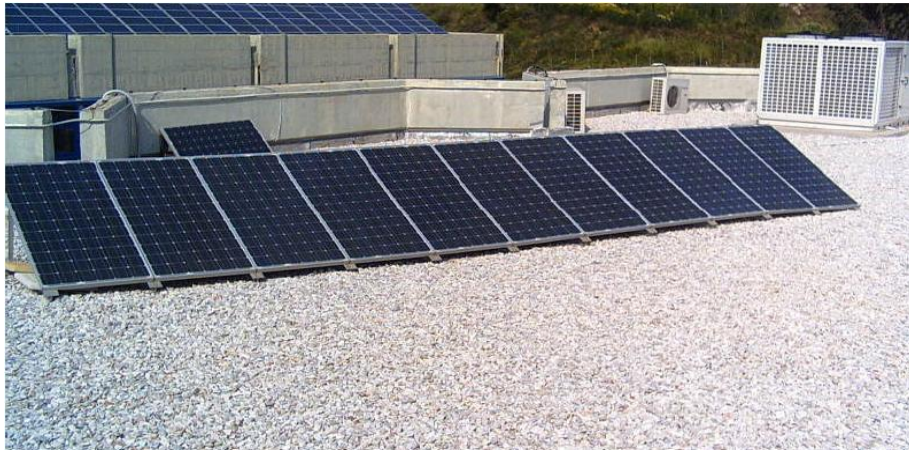
Εικόνα 2.3 Οι φωτοβολταϊκοί συλλέκτες του εργαστηριακού μικροδικτύου
