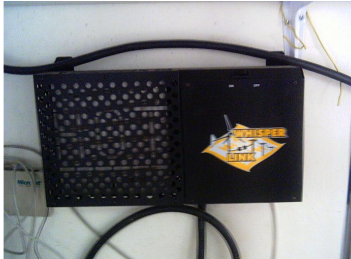
Εικόνα 2.14 Whisper link, ο ανορθωτής της ανεμογεννήτριας του μικροδικτύου
