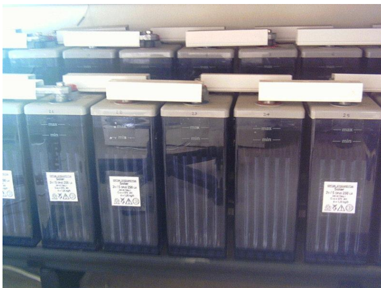
Εικόνα 2.18 Συσσωρευτές μικροδικτύου
