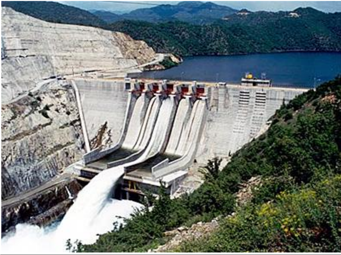
Εικόνα 1.1.1 Υδροηλεκτρικός σταθμός Πλατανόβρυσης Δ.Ε.Η.
