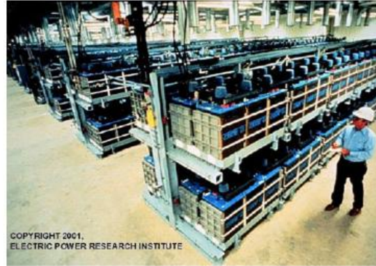
Σχήμα 2. 7 Εφαρμογή των μπαταριών μολύβδου-οξέως σε ESS.
