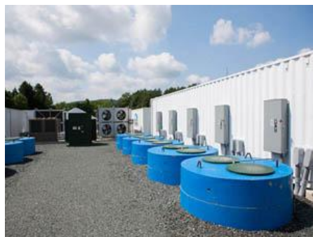
Σχήμα 2.7 Εφαρμογή ενός ESS με σφονδύλους από την Beacon Power ( http://www.cleanenergyactionproject.com/CleanEnergyActionProject/CS.Beacon_Power_Stephentown_Advanced_Energy_Storage_Energy_Storage_Case_Study.html )
