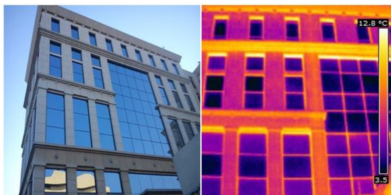
Εικόνα 4.6: Δυτική όψη του κτιρίου
