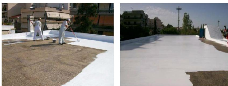
Εικόνα 5.1: Εφαρμογή του ψυχρού υλικού σε στέγη κτιρίου
