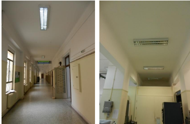
Σχήμα 4.15: Μεγάλο ύψος τοποθέτησης φωτιστικών – απουσία κρέμασης
