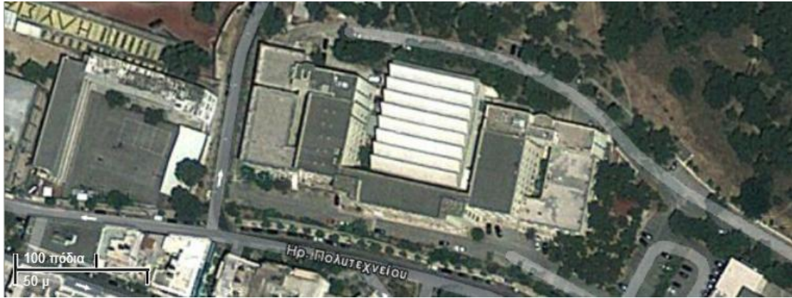
Σχήμα 4.1: Φωτογραφία του κτηρίου Αντοχής Υλικών από δορυφόρο [Πηγή: Google Earth]
