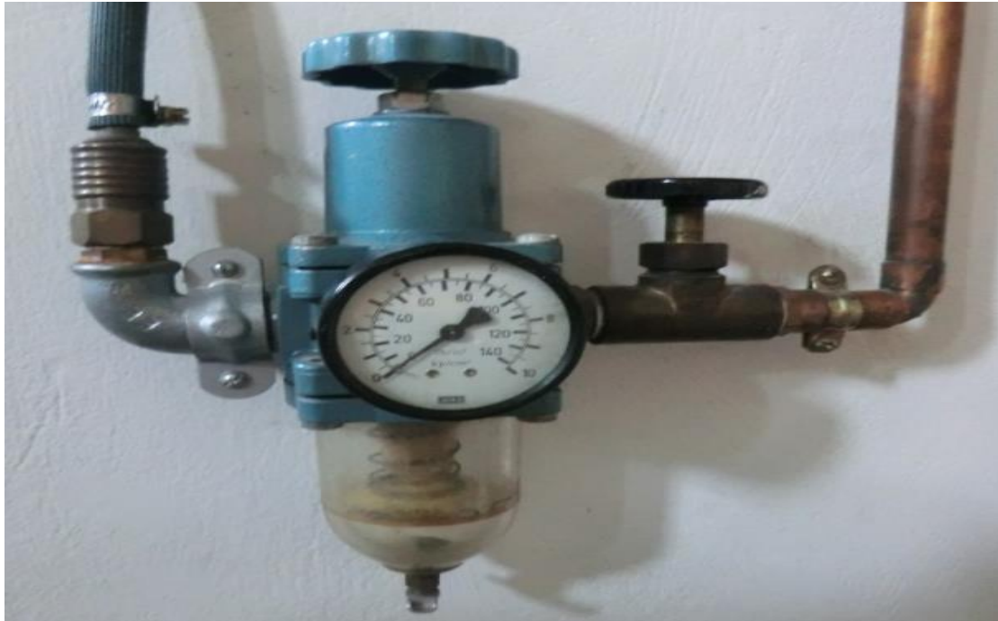
Σχήμα 8.15: Βαλβίδα συστολής για τη σύνδεση του δοχείου πίεσης με το σύστημα παροχής αέρα του εργαστηρίου υψηλών τάσεων
