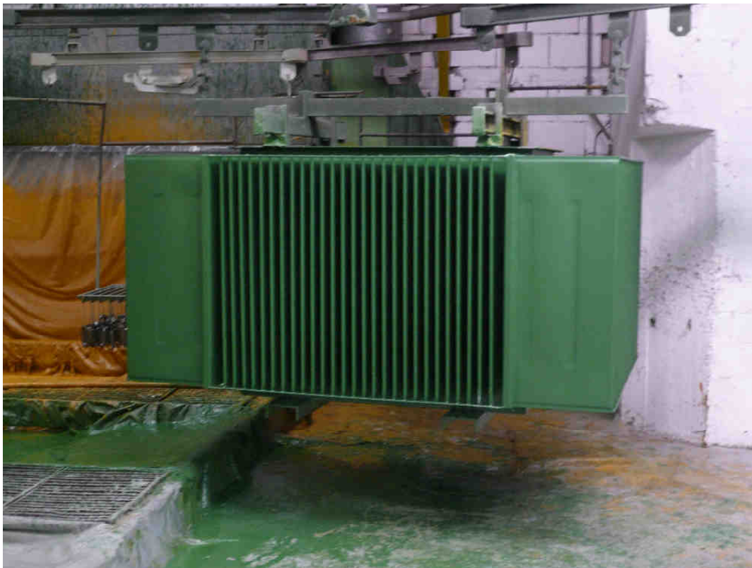
Εικόνα 3.12 - Δεύτερη στρώση ασταρώματος
