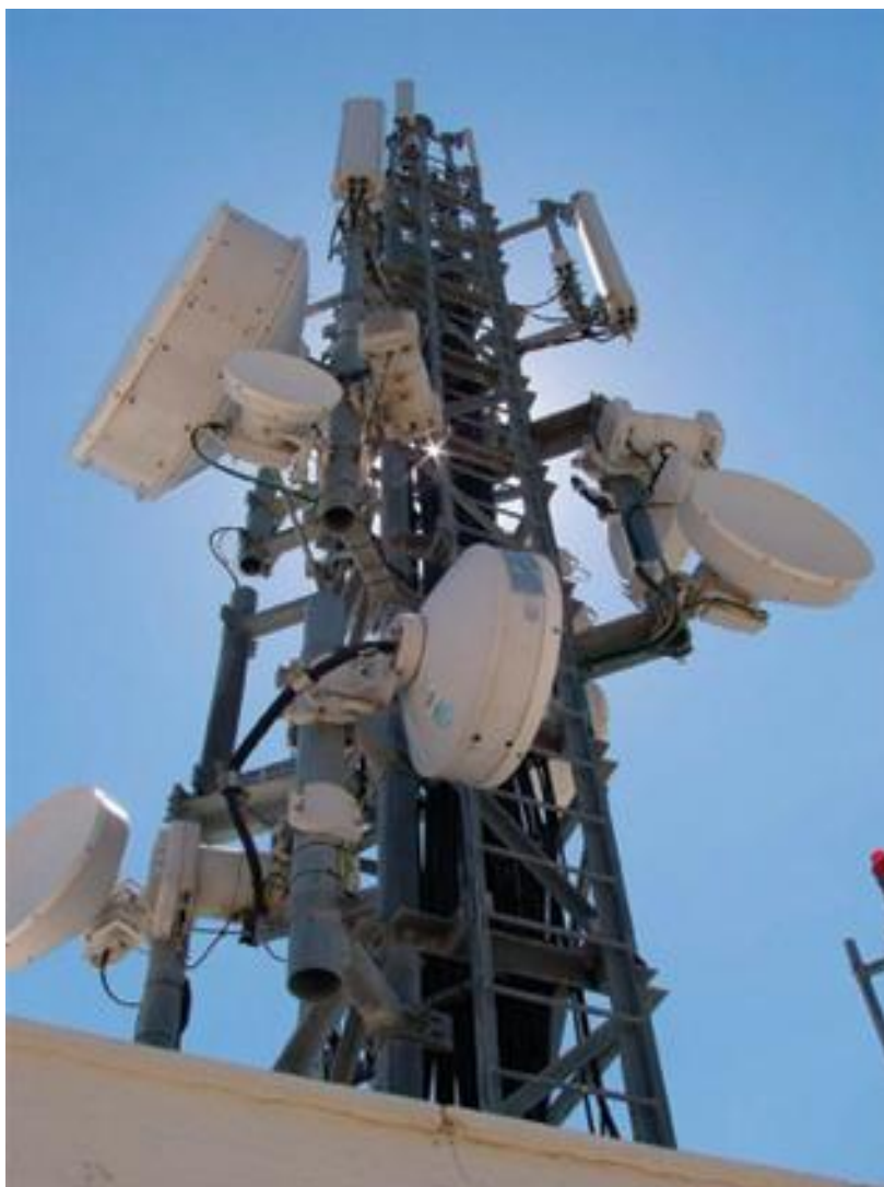
Εικόνα 4.1: Φωτογραφία Σταθμού βάσης
