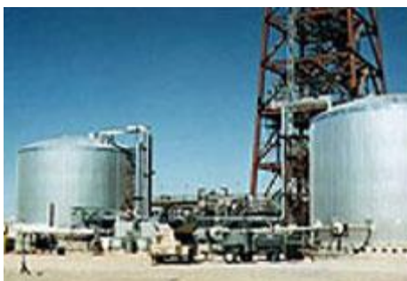
Σχήμα 5.3: Άμεσο σύστημα αποθήκευσης δυο δεξαμενών.
