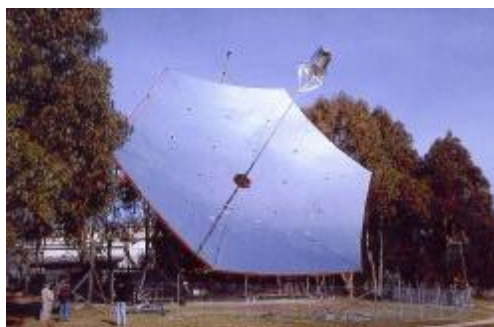
Σχήμα 2.10: Το σύστημα ηλιακού πιάτου Big Dish.
