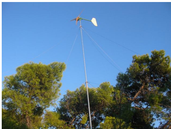
Εικόνα 1.1 : τοποθέτηση ανεμογεννήτριας για σύνδεση στο δίκτυο (Ραφήνα)
