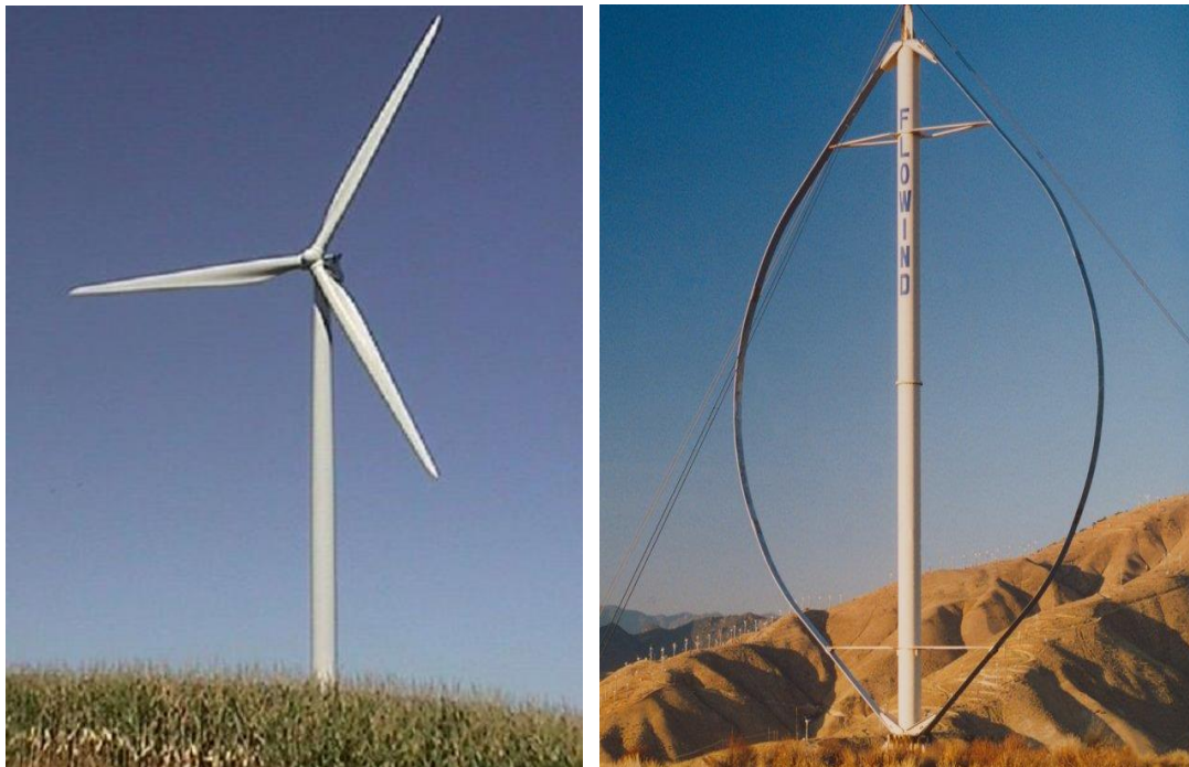
Σχήμα 1.5.2 Ανεμογεννήτριες α) Οριζόντιου άξονα και β) Κατακόρυφου άξονα
