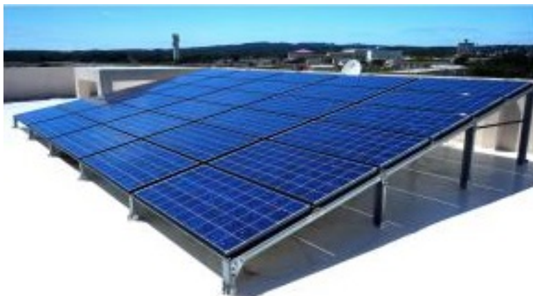
Σχήμα 4.12: Φωτοβολταϊκά πλαίσια αποτελούμενα από φωτοβολταϊκά στοιχεία πολυκρυσταλλικού πυριτίου.
