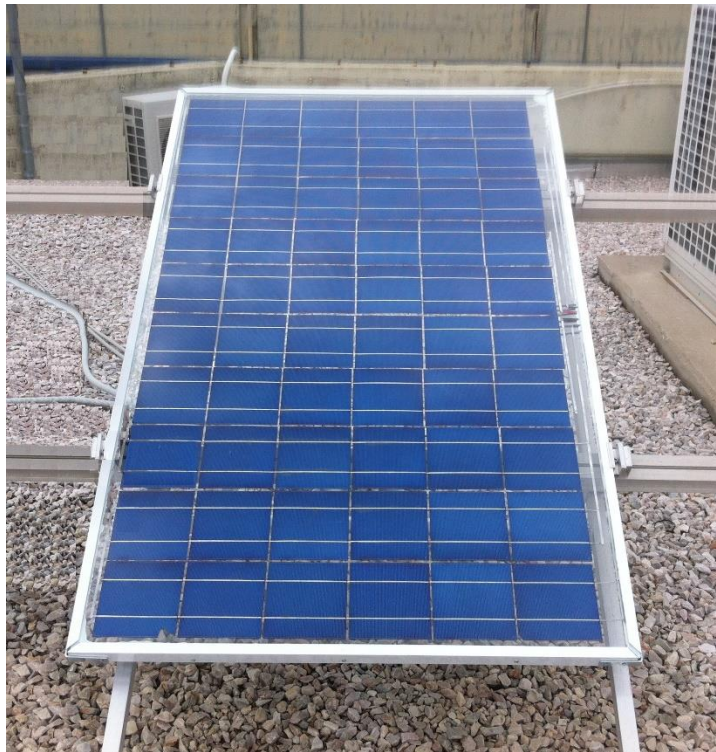
Σχήμα 8.5 Φωτογραφία από την εγκατάσταση του πλαισίου στην ταράτσα του εργαστηρίου ΣΗΕ.
