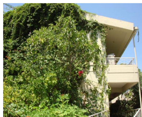
Εικόνα 3.17: ΝΑ όψη Κτιρίου Γ
