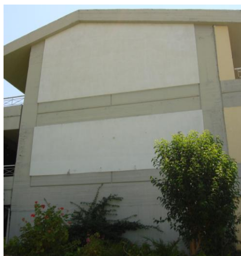
Εικόνα 3.9: ΒΔ όψη Κτιρίου Α
