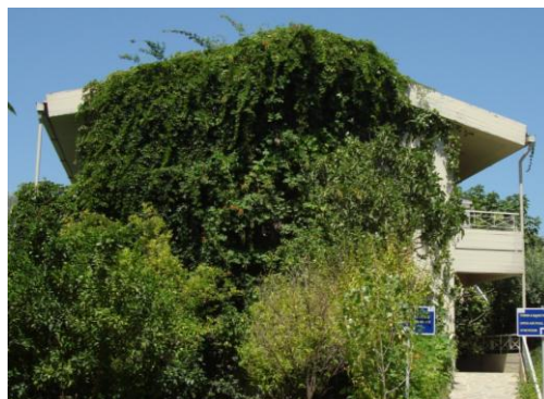
Εικόνα 3.14: ΝΑ όψη Κτιρίου Β
