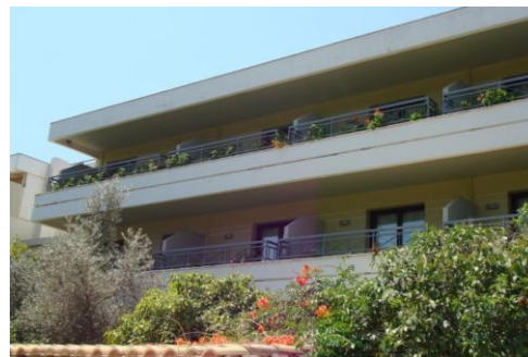
Εικόνα 3.7: Ανατολική όψη Κεντρ. Κτ
