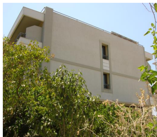
Εικόνα 3.6: Βόρεια όψη Κεντρικού Κτιρίου
