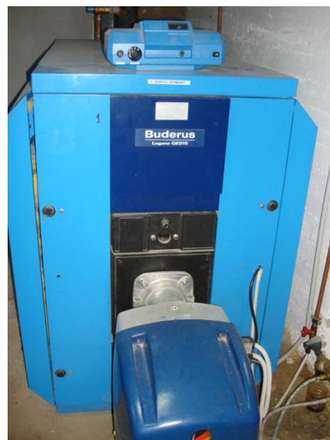
Εικόνα 3.25: Λέβητας πετρελαίου
