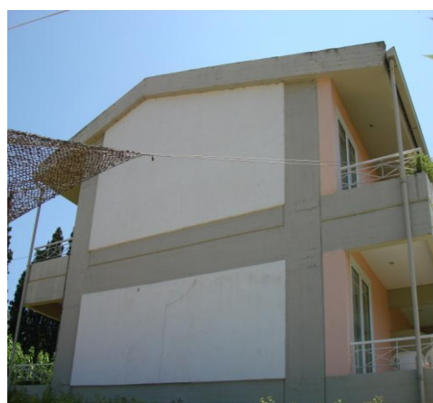
Εικόνα 3.12: ΒΔ όψη Κτιρίου Β
