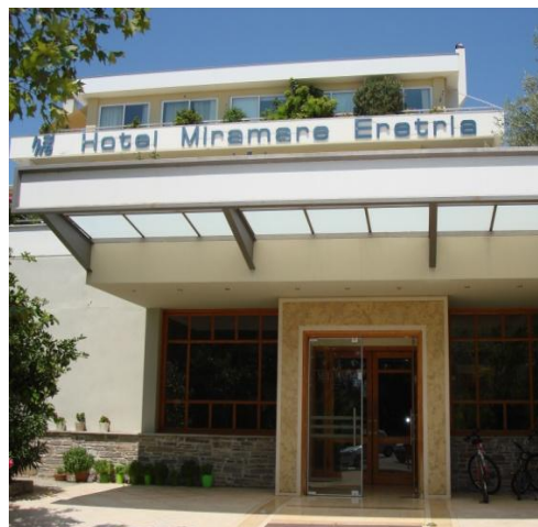
Εικόνα 3.8: Νότια όψη Κεντ. Κτιρίου
