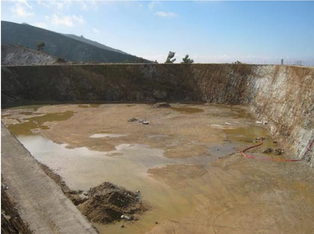
Εικόνα 5-2: Κατασκευή άνω Δεξαμενής
