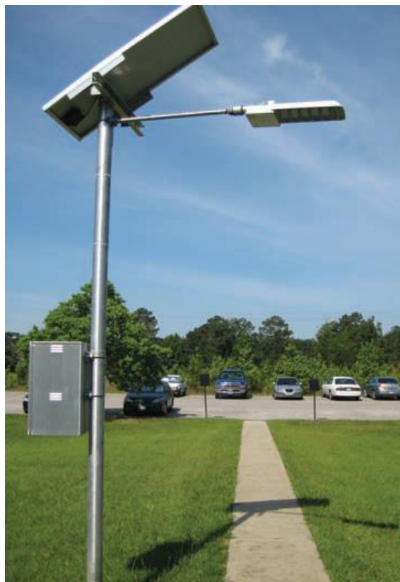
Σχήμα 5.5: Φωτοβολταϊκό σύστημα φωτισμού
