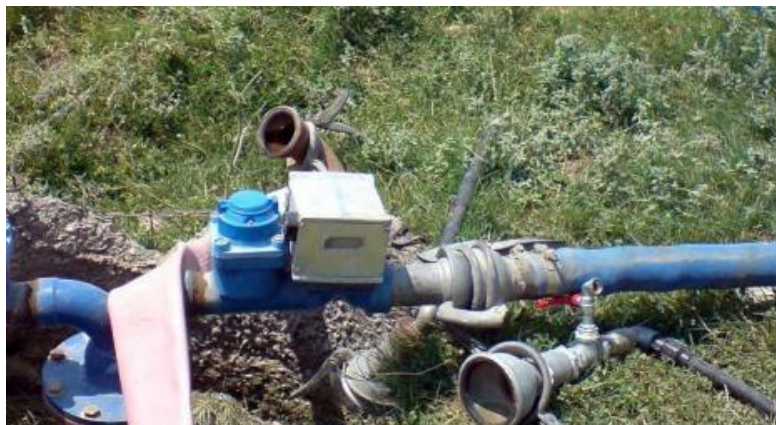
Εικόνα 5.2 Ηλεκτρονικό υδρόμετρο με κάρτα. Στο ειδικό υδροστόμιο, ο αγρότης εισάγει την πιστωτική του «κάρτα» και αυτό καταγράφει ηλεκτρονικά και μηχανικά πόσο νερό «φεύγει».
