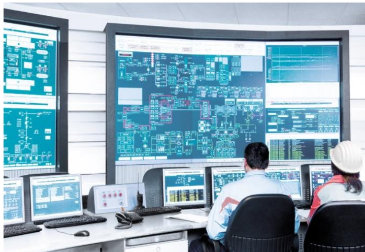
Εικόνα 2-6 Κέντρο Ελέγχου Δικτύου
