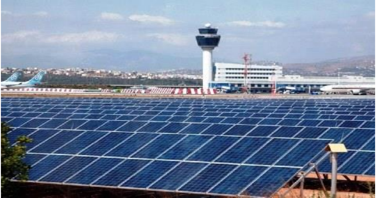
Σχήμα 1.6: Φωτοβολταϊκό πάρκο του Διεθνούς Αερολιμένα Αθηνών
