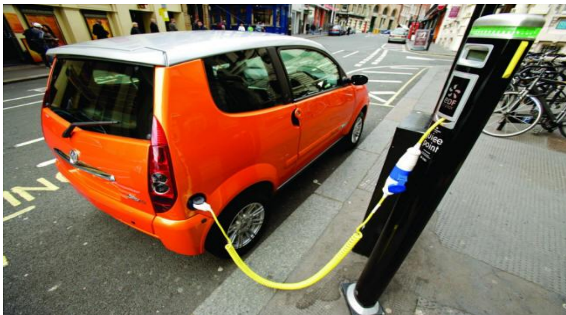
Σχήμα 1.12: Σταθμός ενσύρματης φόρτισης στο Λονδίνο
