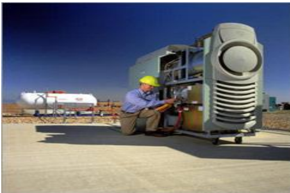
Σχήμα 1.5: Μικροτουρμπίνα
