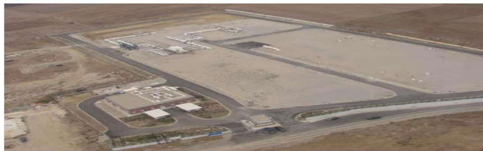
Εικόνα 2.2 Σταθμός Κήποι Έβρου (ΔΕΣΦΑ, Μελέτη Ανάπτυξης ΕΣΦΑ 2013-2022, 2012)
