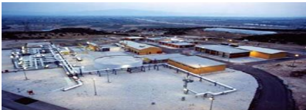
Εικόνα 2.1 Σταθμός Σιδηροκάστρου (ΔΕΣΦΑ, Μελέτη Ανάπτυξης ΕΣΦΑ 2013-2022, 2012)
