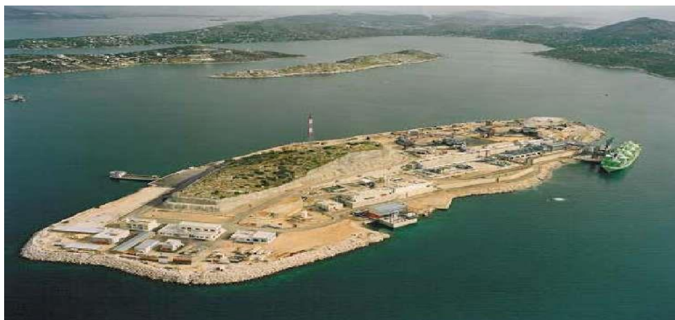
Εικόνα 2.3 Σταθμός Ρεθυθούσας (ΔΕΣΦΑ, Μελέτη Ανάπτυξης ΕΣΦΑ 2013-2022, 2012)
