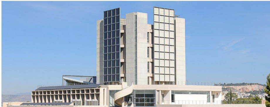
Εικόνα 45 - Φωτοβολταϊκή αδιαφανής πρόσοψη στο κτίριο της Κεντρικής Βιβλιοθήκης του ΕΜΠ [103]
