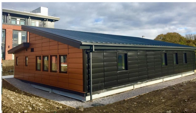
Εικόνα 44 - Φωτοβολταϊκό Σύστημα σε επικλινή στέγη [101]
