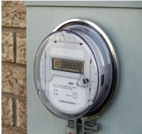
Εικόνα 1.9: Έξυπνος Μετρητής, εγκατεστημένος και σε λειτουργία.
