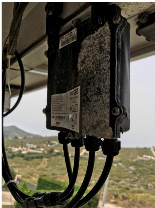
Φωτογραφία 6.8: Οξειδωμένο περίβλημα Power optimizer.
