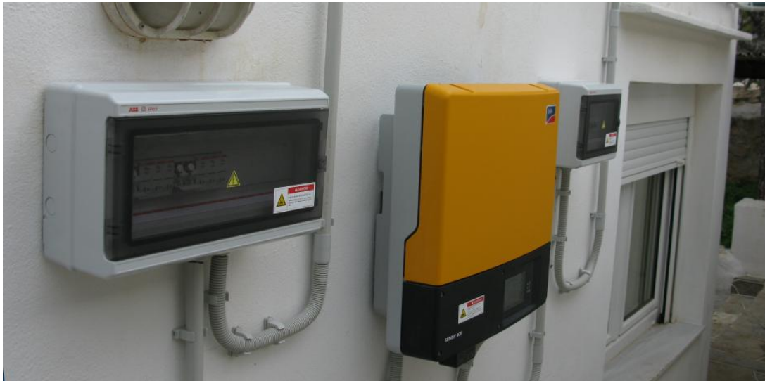
Φωτογραφία 3.1: Διάταξη Πίνακα DC – Inverter – Πίνακα AC (από αριστερά προς τα δεξιά)
