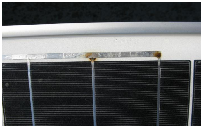
Φωτογραφία 6.21: Κακές κολλήσεις σε ταινιόδρομο φ/β πάνελ που οδήγησαν σε τοπικές υπερθερμάνσεις.
