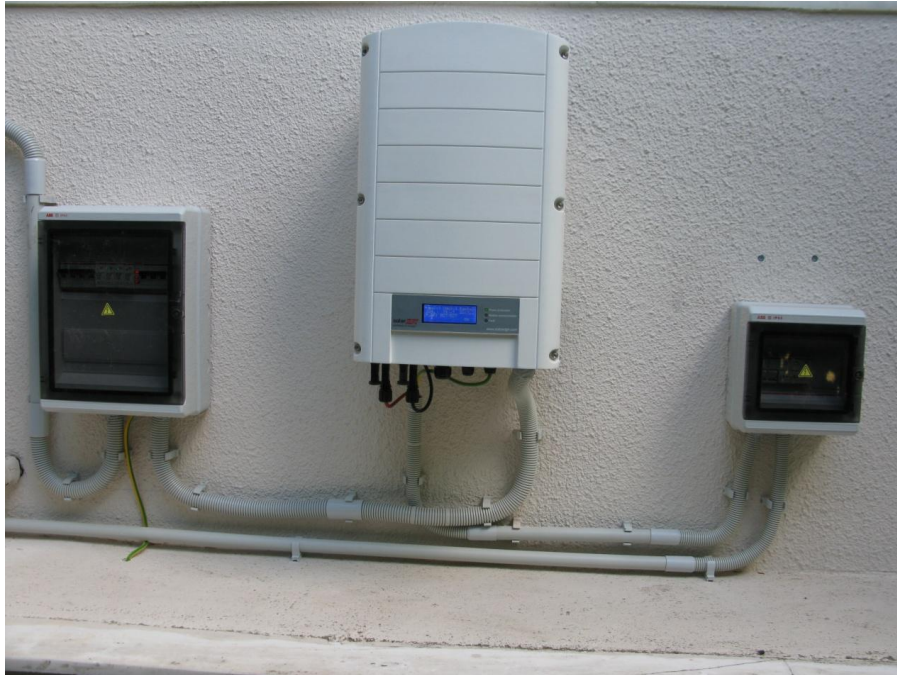
Φωτογραφία 3.4: Διάταξη Πίνακας AC – Inverter – Πίνακα DC (από αριστερά προς τα δεξιά)
