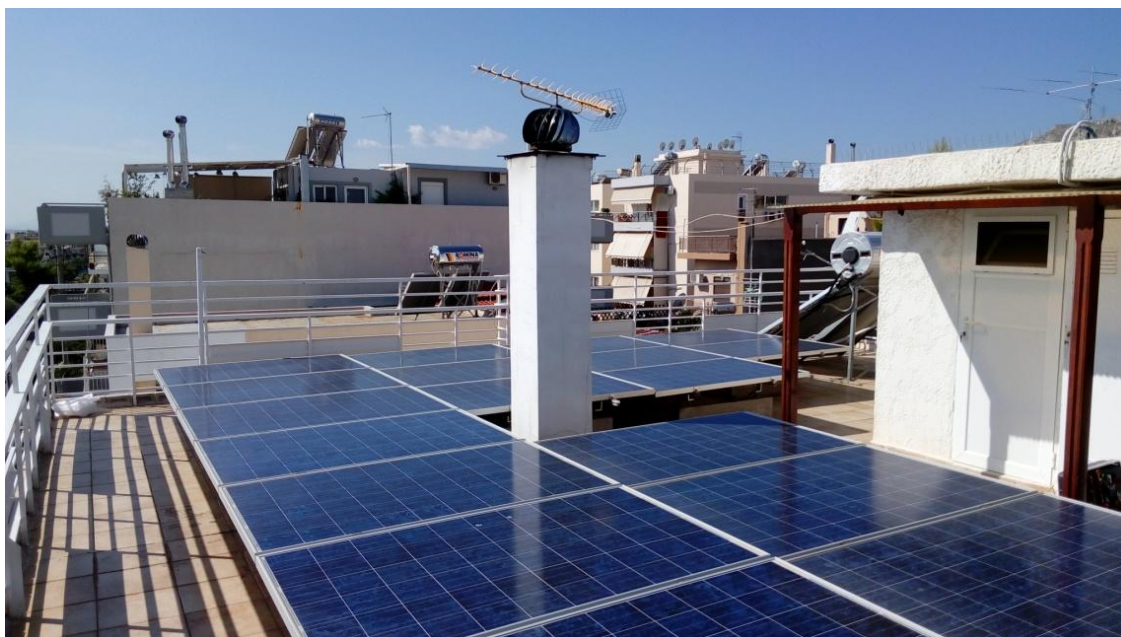
Φωτογραφία 6.1: Πάνελ τοποθετημένα με μηδενική κλίση.
