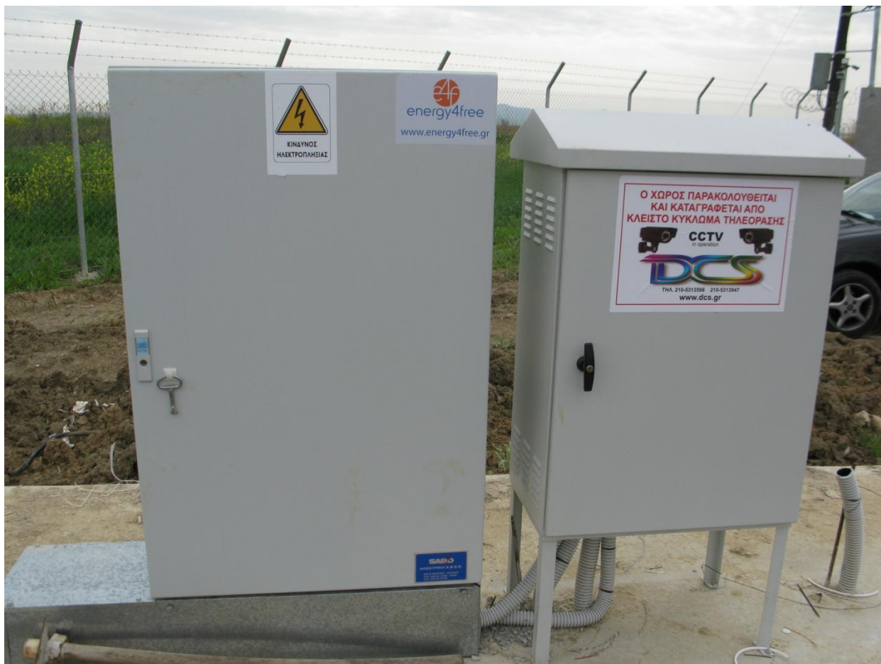
Φωτογραφία 3.10: Κεντρικός πίνακας AC δεξιά πίνακας συναγερμού και καμερών
