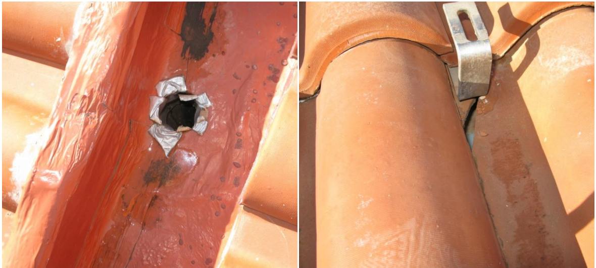
Φωτογραφία 6.19: Προβλήματα υγραμόνωσης σε στέγες μετά την εγκατάσταση φ/β.
