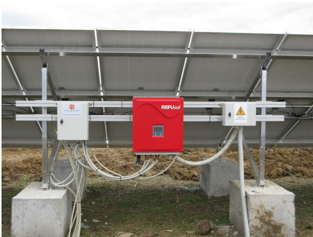
Φωτογραφία 3.9: Διάταξη πίνακα DC – inverter – πίνακα AC (από αριστερά προς τα δεξιά)
