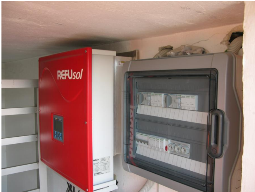
Φωτογραφία 6.28: Λάθος σημείο τοποθέτησης inverter με αποτέλεσμα την αναποτελεσματική ψύξη αυτού και ενεργοποίησης λειτουργίας derating
