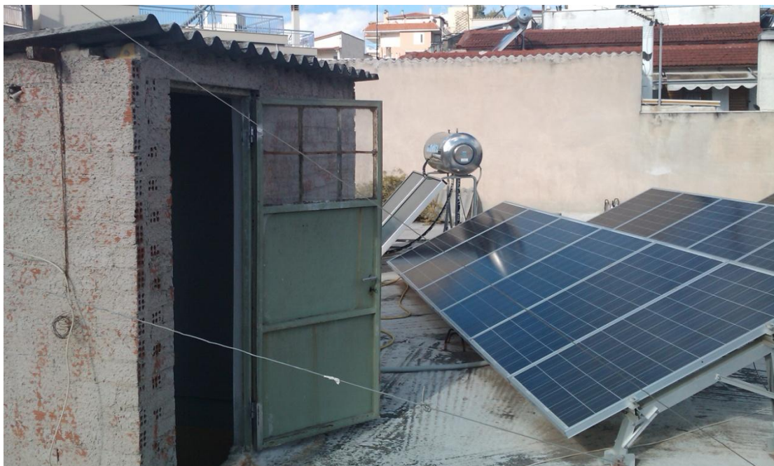
Φωτογραφία 6.3 :Φωτοβολταϊκά πάνελ εγκατεστημένα σε σημείο με μόνιμη σκίαση.
