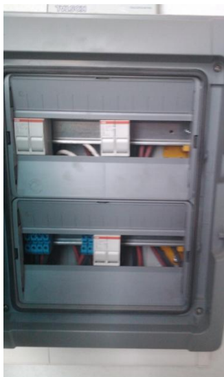
Φωτογραφία 6.18 :Πίνακας DC με 3 ανεξάρτητες στοιχειοσειρές ο οποίος δεν έχει αντικεραυνική προστασία SPDs.
