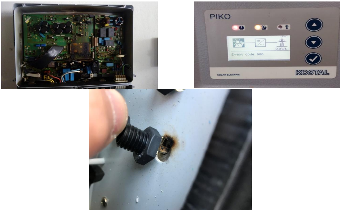
Φωτογραφία 6.16 : Inverter εκτός λειτουργίας λόγω βλαβών
