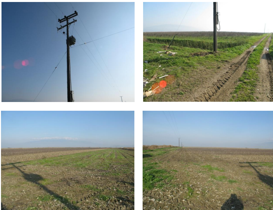
Φωτογραφία 3.7: Στύλος Μ/Σ Μέσης Τάσης ΔΕΔΔΗΕ στην Ν/Α πλευρά του αγροτεμαχίου
