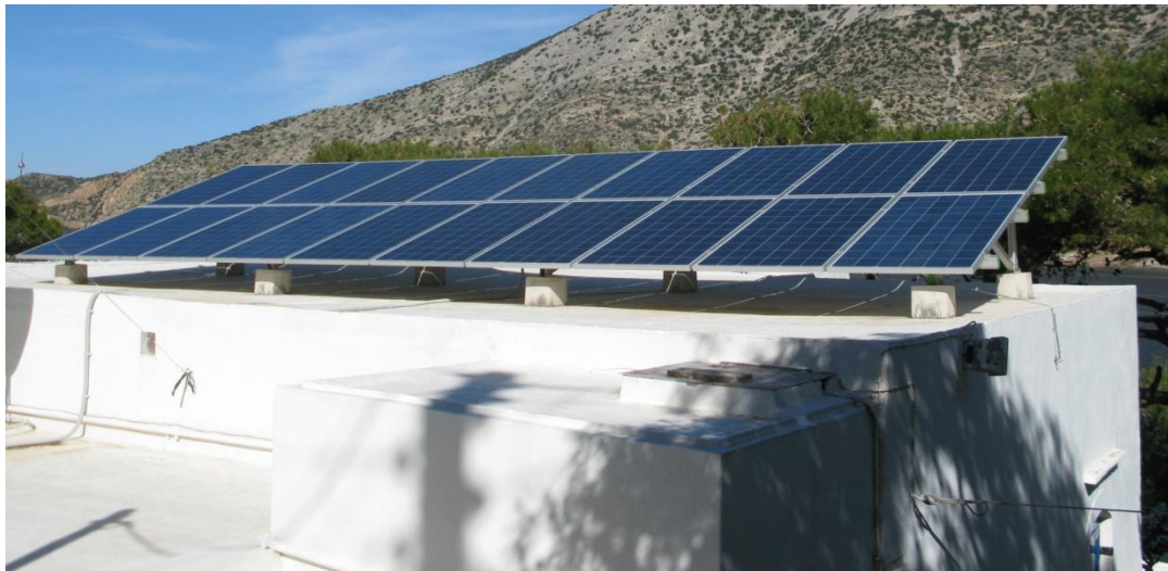
Φωτογραφία 3.2: Η Φωτοβολταϊκή γεννήτρια εγκατεστημένη
