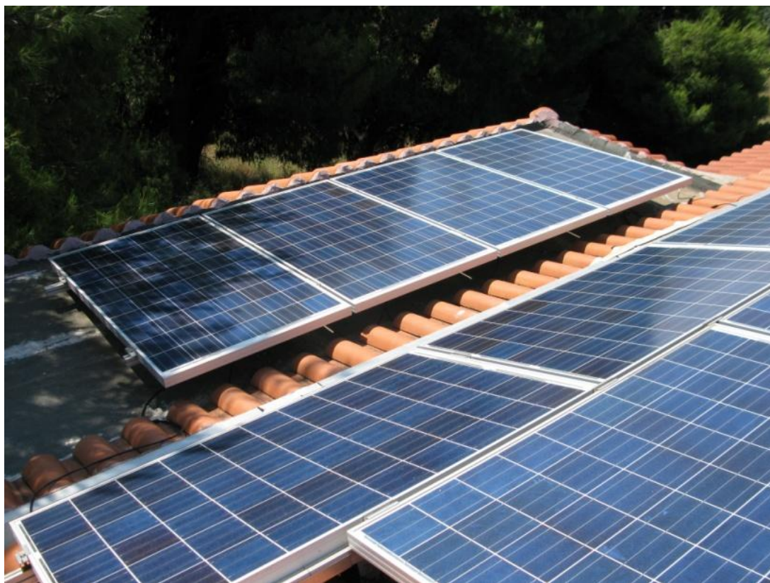
Φωτογραφία 6.2: Φωτοβολταϊκά πάνελ τα οποία ανοίκουν στην ίδια στοιχειοσειρά εγκατεστημένα με 3 διαφορετικές κλίσεις.
