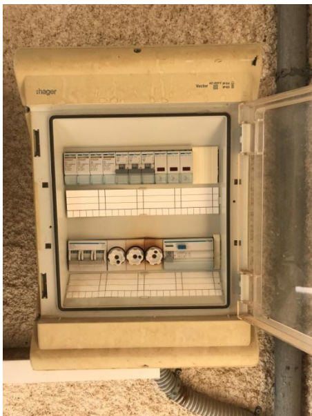
Φωτογραφία 6.10 : Κακές συσφίξεις καλωδίων οι οποίες οδήγησαν σε καταστροφή εξαρτημάτων και βλάβες.
