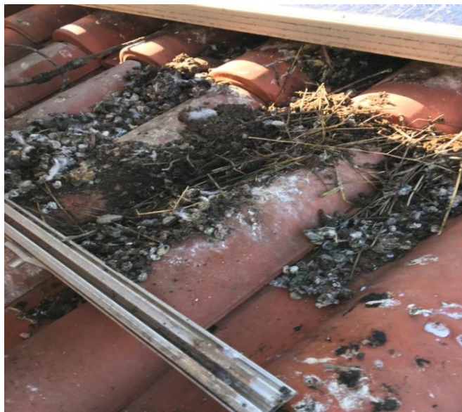
Φωτογραφία 6.31: Περιττώματα πουλιών δημιούργησαν πρόβλημα αντίστασης μόνωσης στην καλωδίωση θέτοντας την εγκατάσταση εκτός λειτουργίας
