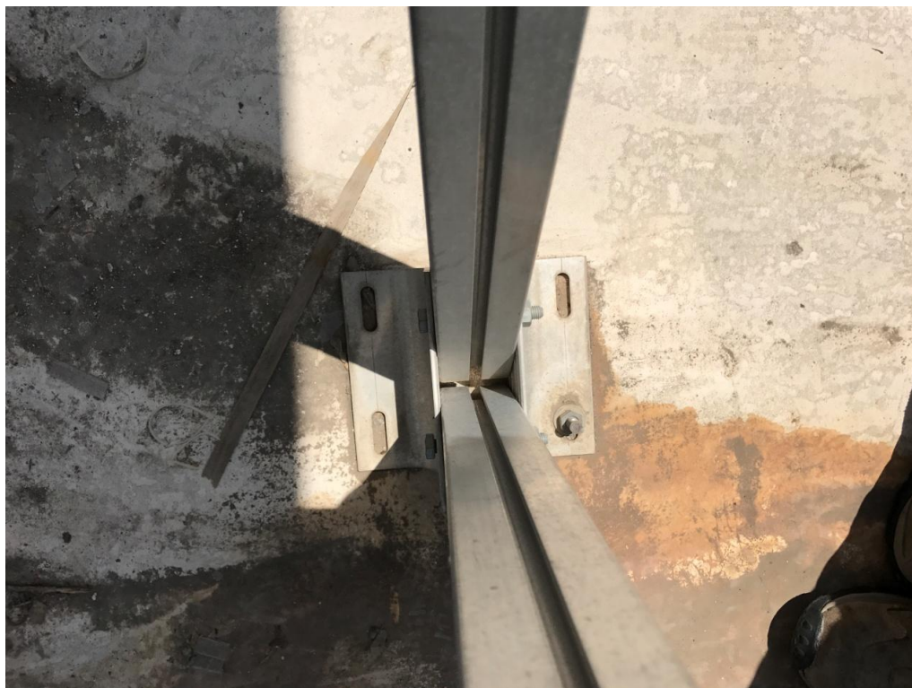
Φωτογραφία 6.5 :Βάση στήριξης χωρίς την προβλεπόμενη από τον κατασκευαστή αγκύρωση
