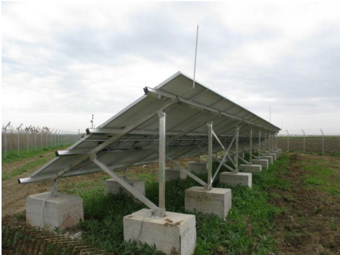
Φωτογραφία 3.8: Άποψη των Φ/Β βάσεων με τις ακίδες τύπου Franklin εγκατεστημένες
