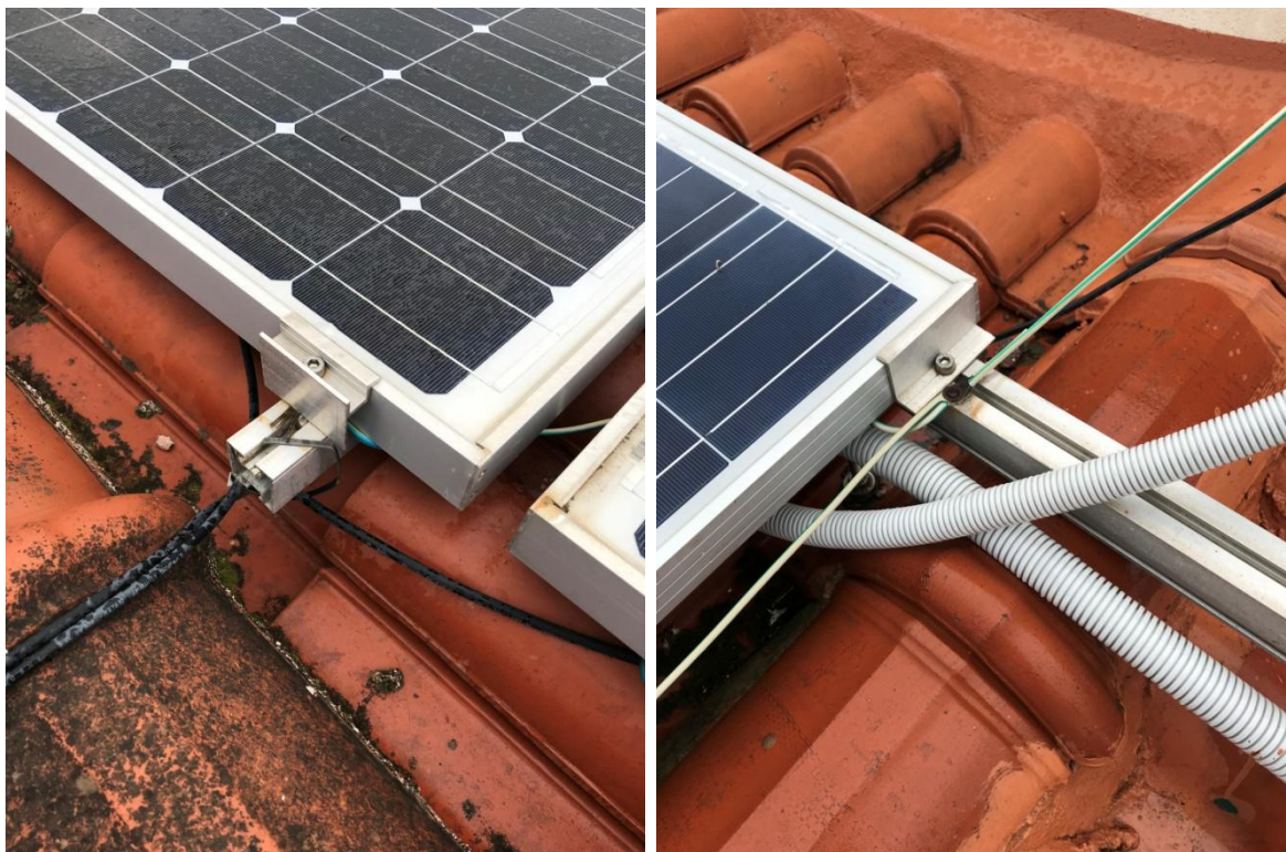
Φωτογραφία 6.7 : Αγωγοί γείωσης τοποθετημένοι σε Φ/Β βάσεις στήριξης χωρίς τους κατάλληλους συνδέσμους σύνδεσης.
