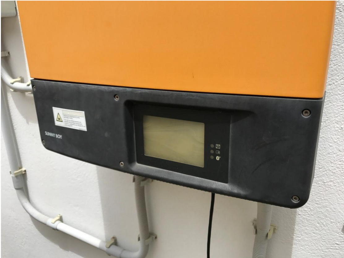
Φωτογραφία 6.9: Πολυμερισμένο καπάκι οθόνης inverter
