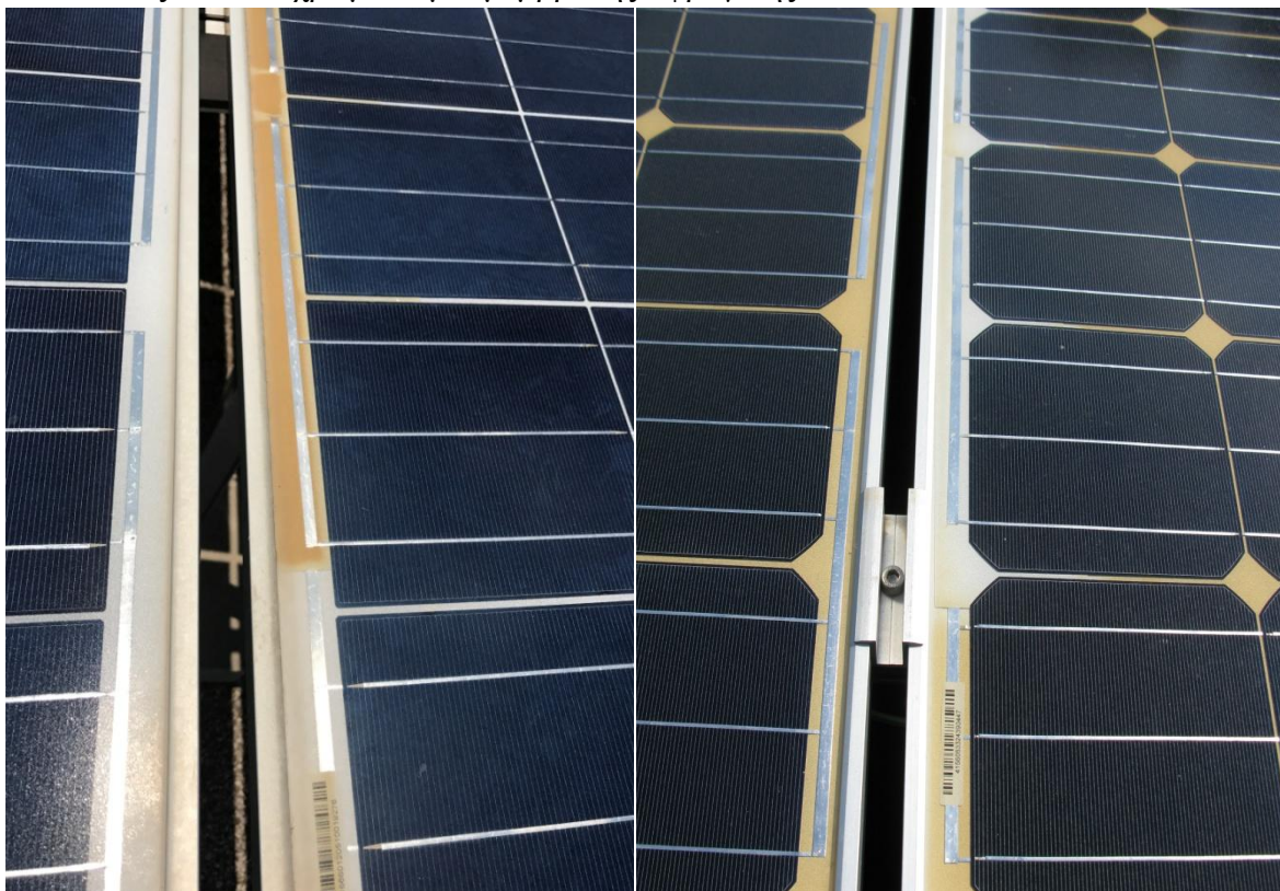
Φωτογραφία 6.25: Αλλοιώσεις μεμβράνης σφράγισης φ/β πλαισίου.
