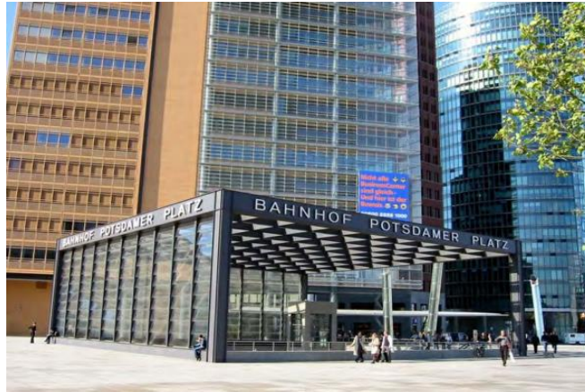
Εικόνα 2.17 Ανακλαστικές εξωτερικές περσίδες στην πρόσοψη κτιρίου στην Postdamer Platz του Βερολίνου [33]
