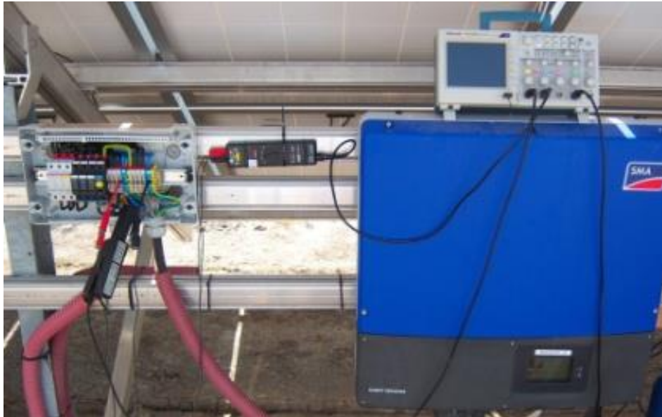
Εικόνα 3.1. Γενική άποψη της τοπολογίας μετρήσεων. Αριστερά οι μετρητές εξ επαγωγής ρεύματος και το βολτόμετρο στην πλευρά εναλλασσόμενου ρεύματος. Τοποθετημένος επί του αντιστροφέα SMA Sunny Tripower 17000TL-20 ο ψηφιακός παλμογράφος καταγραφής.
