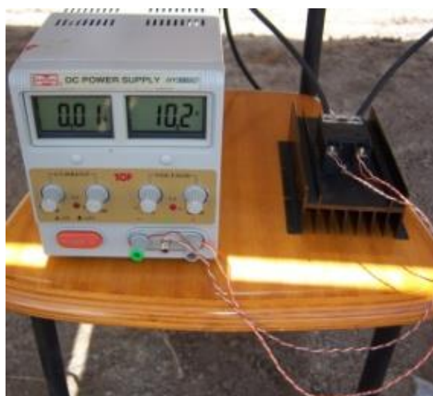
Εικόνα 3.2. Ρελέ συνεχούς ρεύματος ελέγχου στοιχειοσειράς και τροφοδοτικό οδήγησής του.
