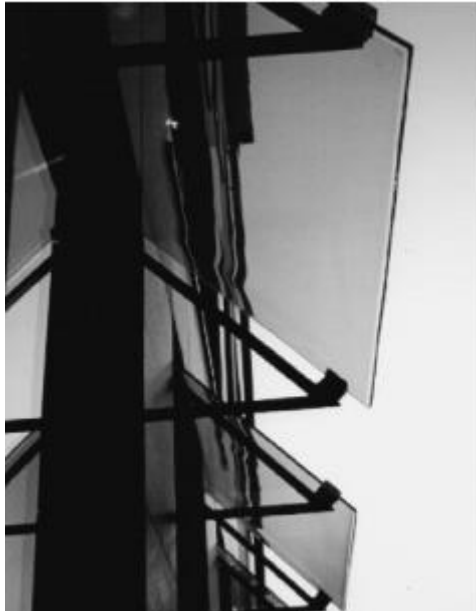
Εικόνα 5.11: Εξωτερική εγκατάσταση υαλοπίνακα ανακατεύθυνσης φωτός [πηγή: Daylight in buildings A source book on daylighting systems and components]
