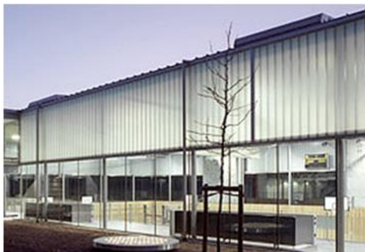
Εικόνα 5.12: Πρόσοψη κτιρίου με διαφανή μονωτικά υλικά. [πηγή: http://www.tsb.wetterau.de/ ]
