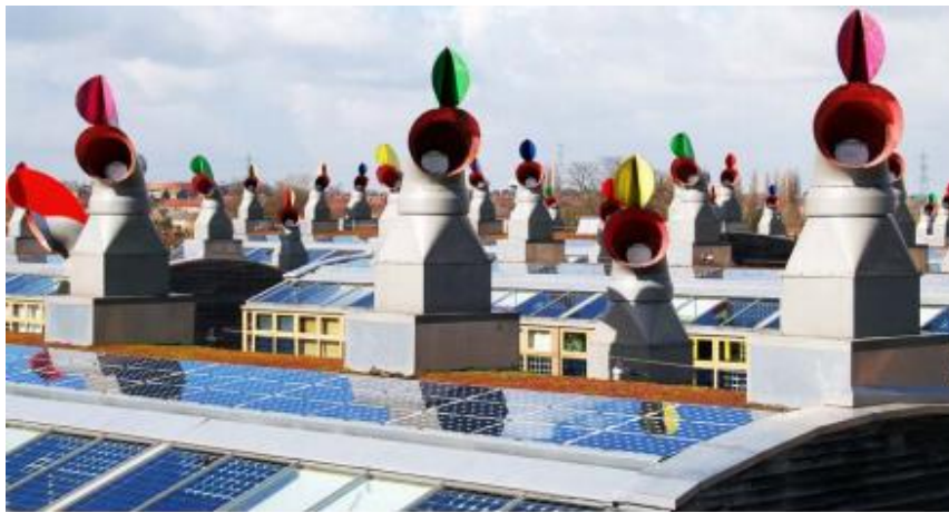
Εικόνα 2.7 'Αιολικές καμινάδες' στην οροφή των κτιρίων και φωτοβολταϊκοί ηλιακοί συλλέκτες
