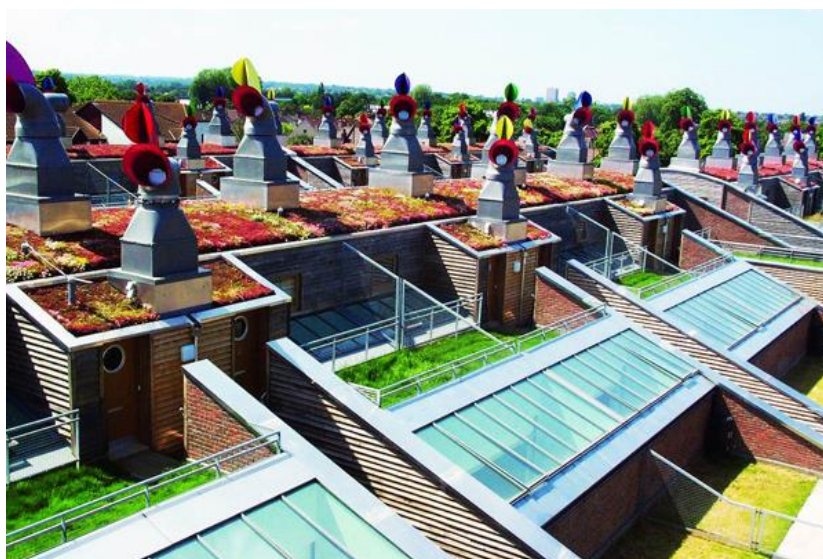
Εικόνα 2.5: Κήποι βόρειας όψης όπου φαίνονται οι φεγγίτες για την παροχή φυσικού φωτός στους χώρους εργασίας.[πηγή: www.zeroenergybuildings.org ]
