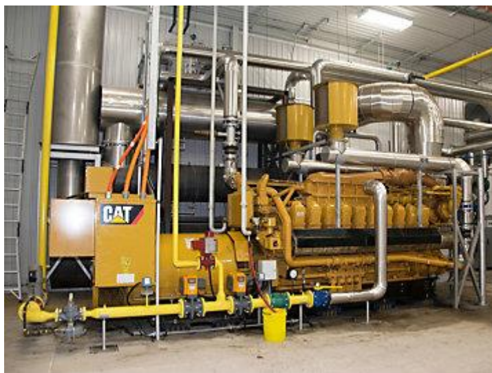
Εικόνα 4.4: Εγκατεστημένο σύστημα ΣΗΘ [πηγή: www.cat.com/en_GB/by-industry/electric-power-generation/electric-power-industries/cogen-chp.html ]
