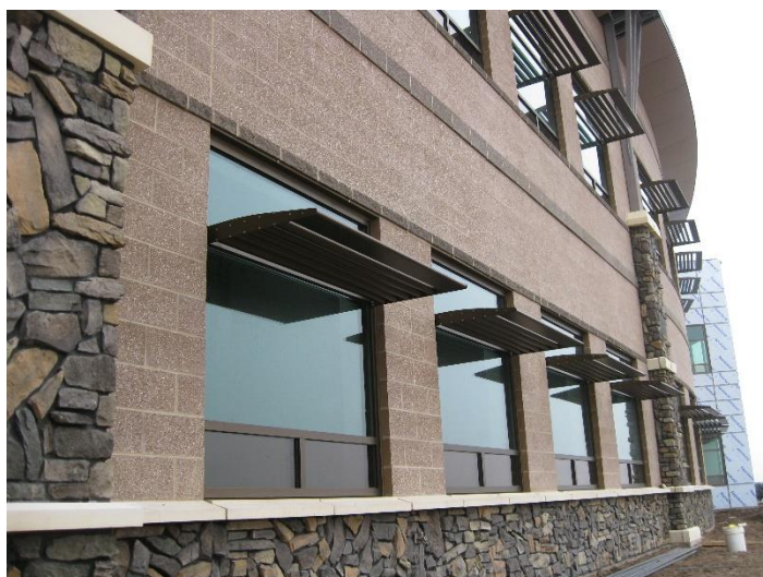
Εικόνα 5.3: Ράφι φωτισμού [πηγή: https://www.haikudeck.com/light-shelf-science-and-technology-presentation-TrCZQFCLPz#slide0 ]
