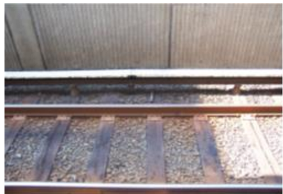
Εικόνα 1.15 Παράδειγμα γραμμής παροχής ηλεκτρικής ισχύος (750V) [28]
