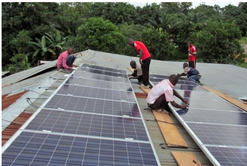
Εικόνα 1.6 Εγκατάσταση φωτοβολταϊκών πάνελ στην οροφή κτιρίου στη Σιέρα Λεόνε [7]
