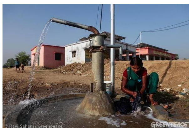
Εικόνα 1.4 Αντλία νερού τροφοδοτούμενη από το αυτόνομο DC σύστημα [6]
