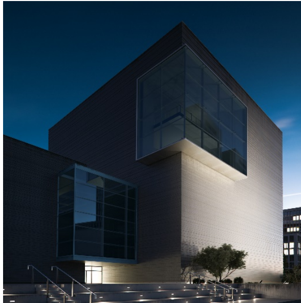
Εικόνα 2-10: Παράδειγμα wall washing (Πηγή: bega.com)
