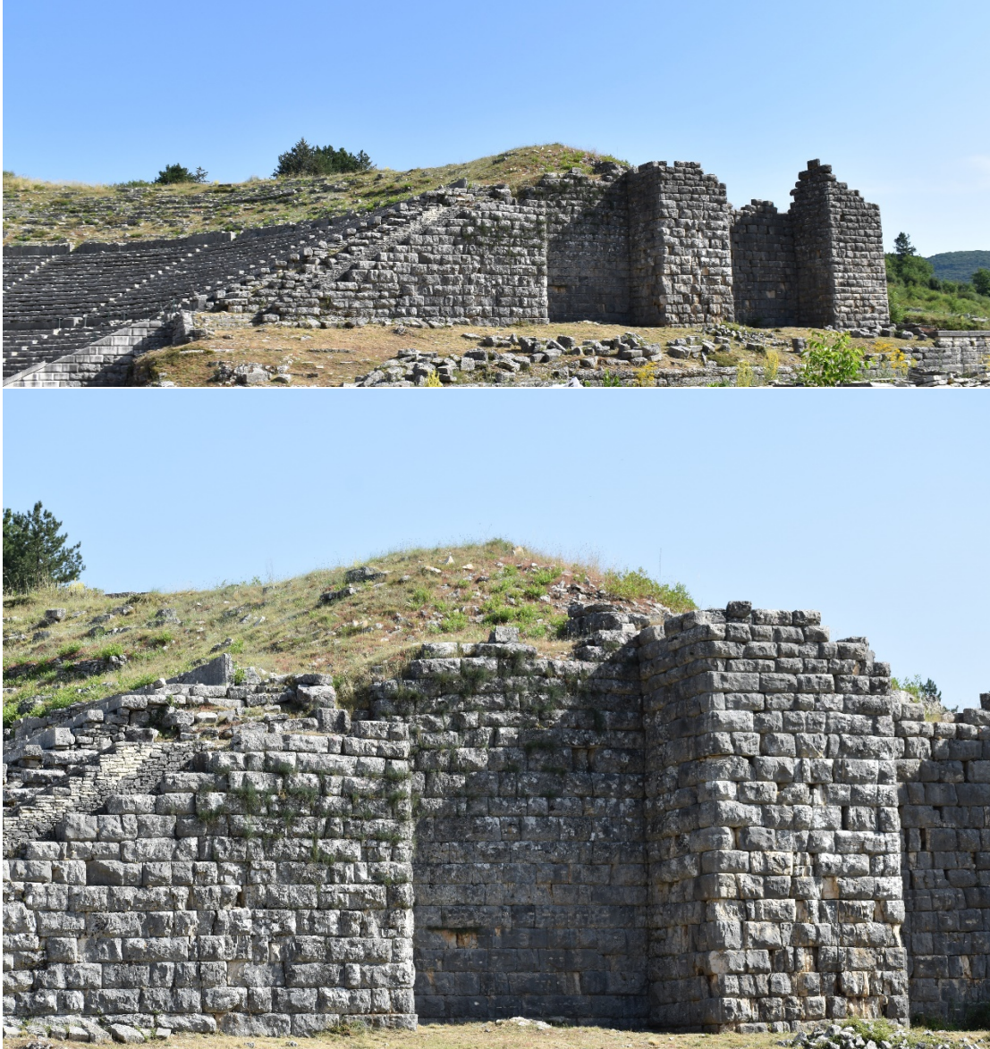
Εικόνα 5-15 Το ανατολικό τμήμα των αναλημματικών τοίχων
