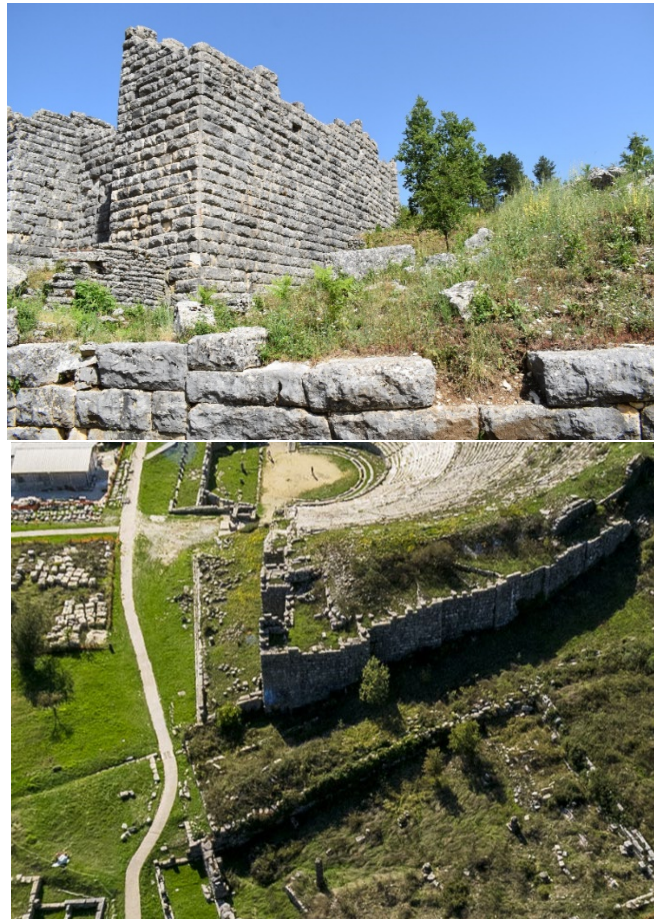
Εικόνα 5-21 Το βορειοανατολικό τμήμα των αναλημματικών τοίχων
