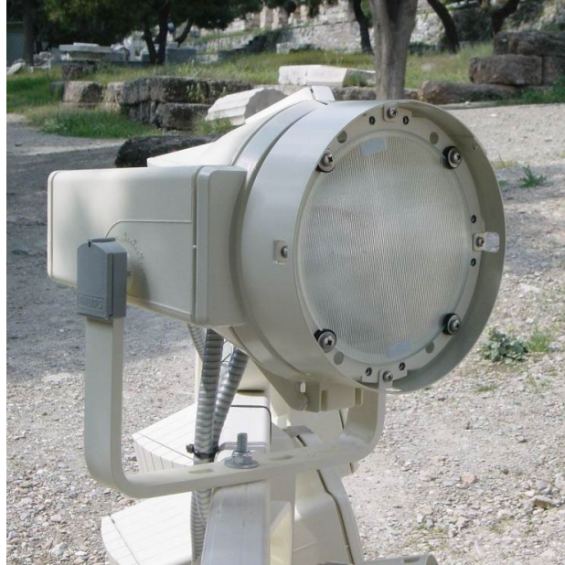
Εικόνα 3-17 Προβολέας philips decoflood mvf-605, mb/150w/830 με πολωτικό φίλτρο προέκτασης της δέσμης και βαμμένος σε ral 1016 για να ταιριάζει με τα μάρμαρα (μνημεία ακροπόλεως και αρχαίο θέατρο Διονύσου) (Πηγή: Κώστας Κάπος)
