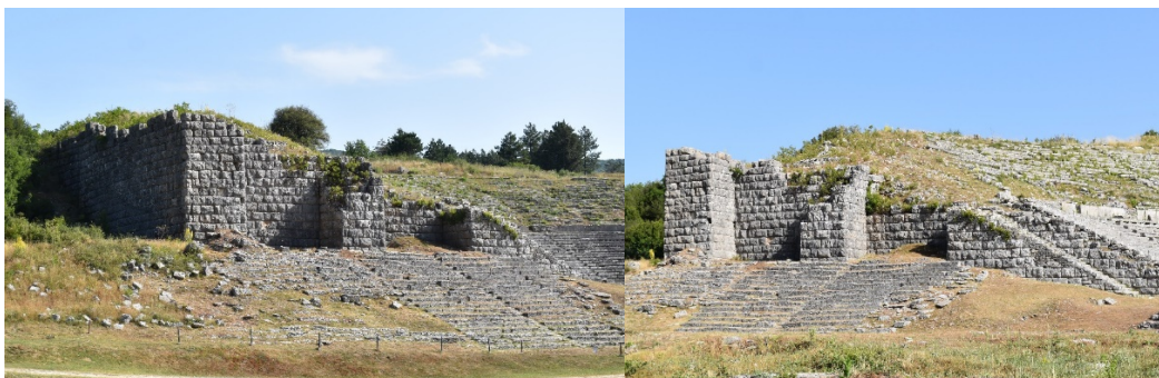
Εικόνα 5-8 Το δυτικό τμήμα των αναλημματικών τοίχων
