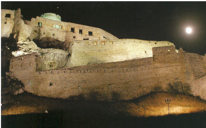
Εικόνα 3-39 3.5.6 Φωτισμός του Κάστρου Spis στην Σλοβακία [8]
