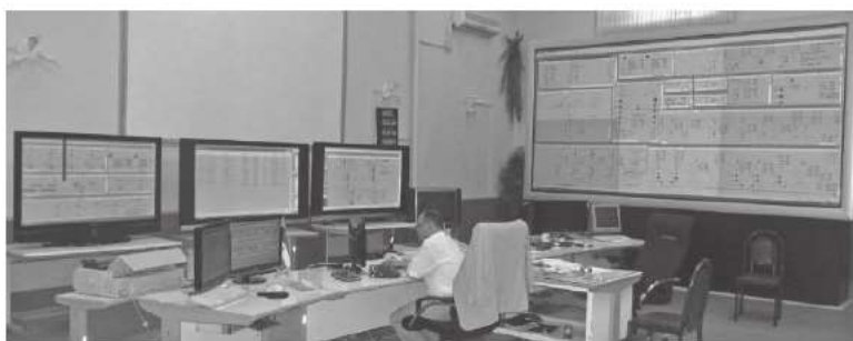
Σχήμα 12: Σύγχρονο κέντρο Διαχείρισης Λειτουργίας και Λήψης Αποφάσεων παραγωγής και ελέγχου ισχύος
