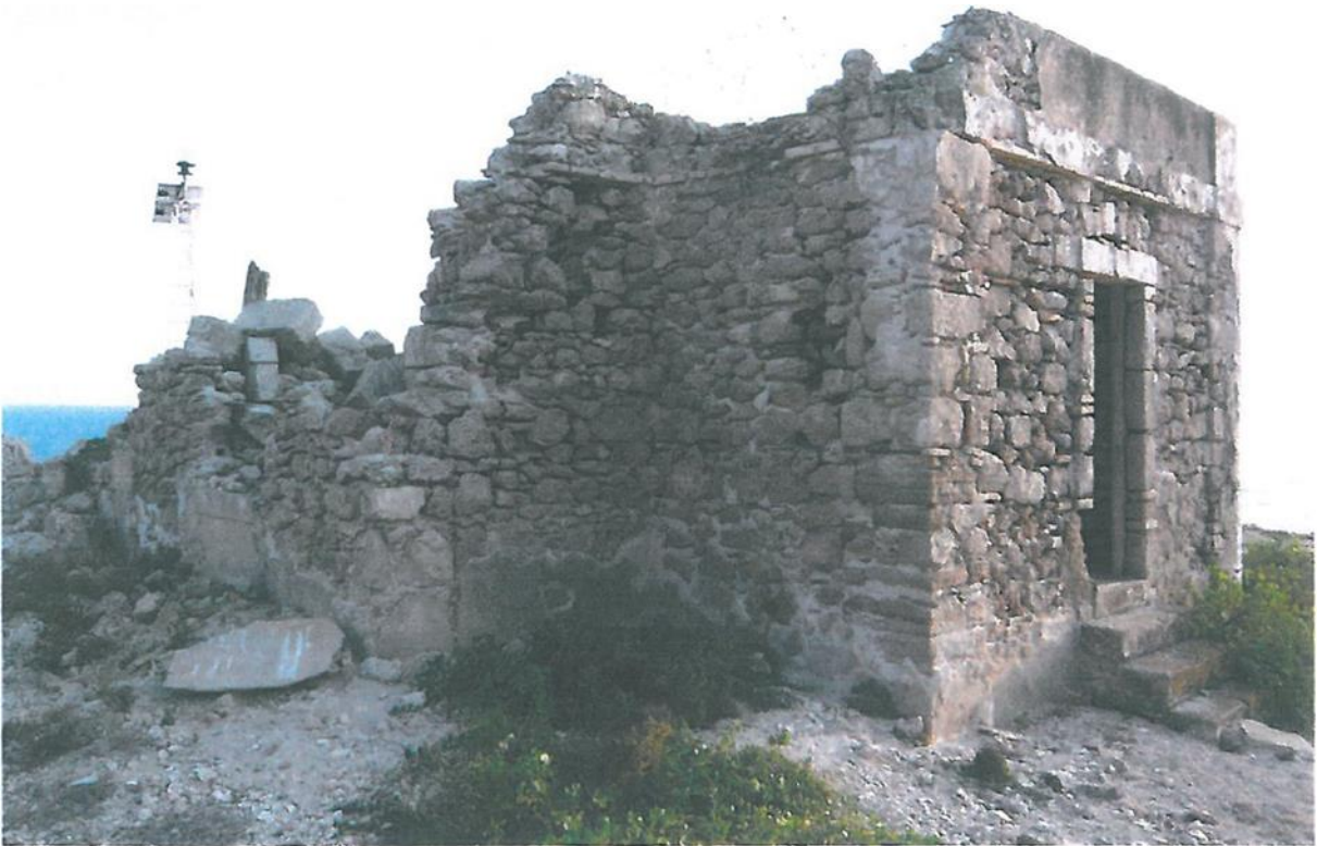
Εικόνα 65: Άποψη του Φάρου από βορειοανατολικά με την κυρία είσοδο στα βόρεια (Πηγή: Πανέτσος et al. , 2010)
