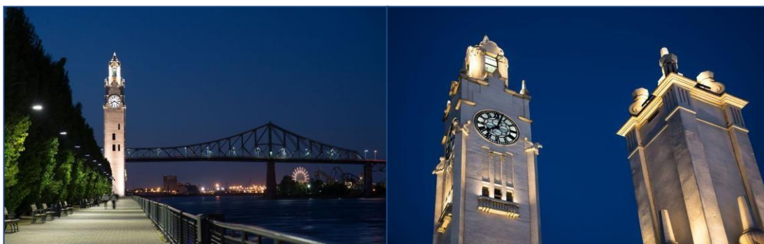
Εικόνα 3: Φωτισμός από κάτω προς τα πάνω (up lighting), Montreal Clock Tower Pier (Πηγή: Project of lumenpulse, http://www.lumenpulse.com )
