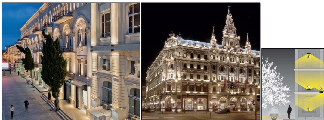
Εικόνα 31: Φωτισμός τονισμού πρόσοψης κτηρίου με επιτοίχια φωτιστικά.
