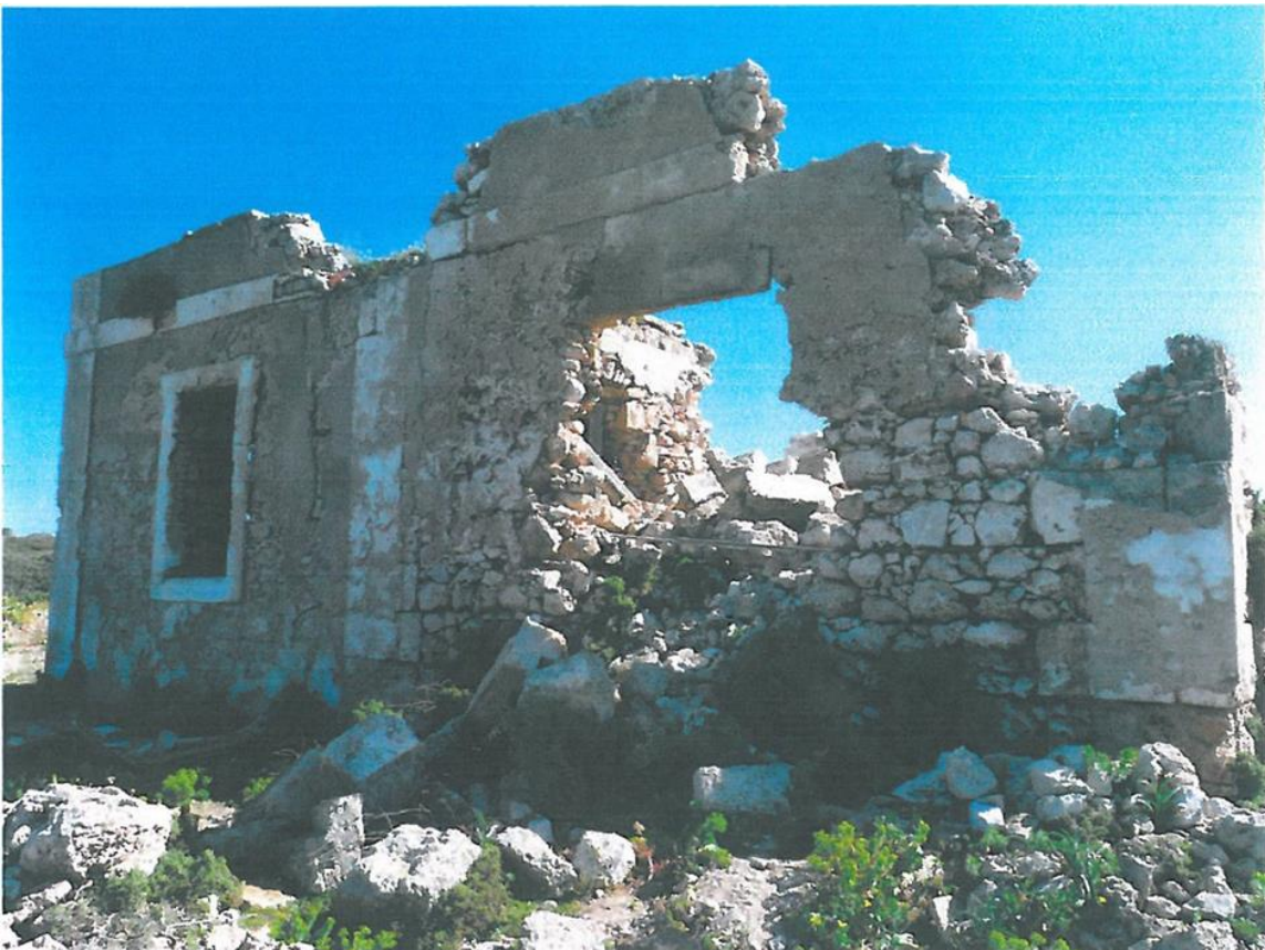
Εικόνα 68: Άποψη της δυτικής πλευράς του Φάρου όπως διατηρείται σήμερα
