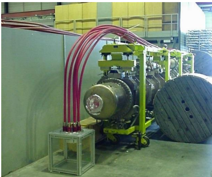
Εικόνα 9: Ομοαξονικά καλώδια και σύνδεσμοι 20Ω [39]
