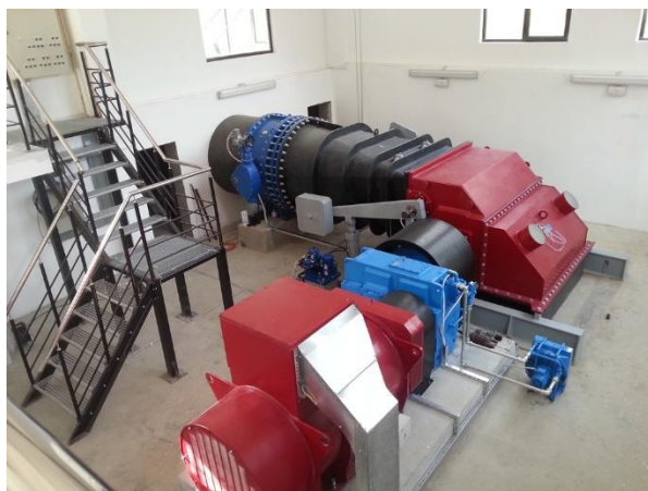
Σχήμα 2.3.7 Στρόβιλοι τύπου CrossFlow [28] [29]
