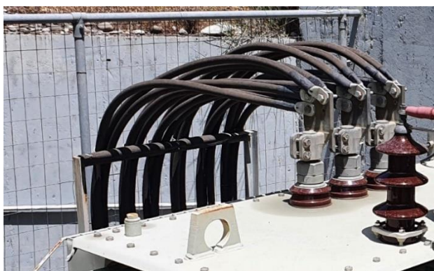
Εικόνα 2.6.1 Σύνδεση Μ/Σ με πολλαπλά καλώδια τύπου E1VV-S 1G120
