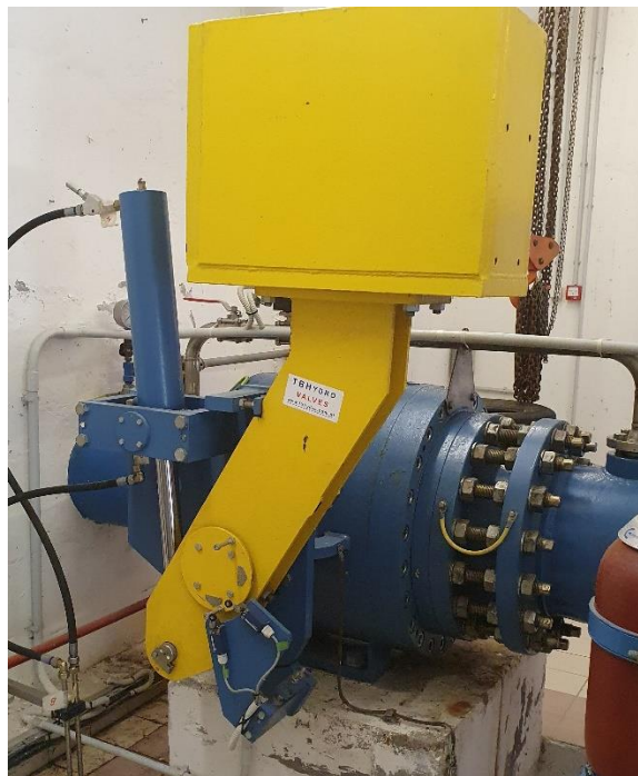
Εικόνα 3.3.4 Βάνα πεταλούδας με υδραυλικό έμβολο για άνοιγμα και αντίβαρο για κλείσιμο
