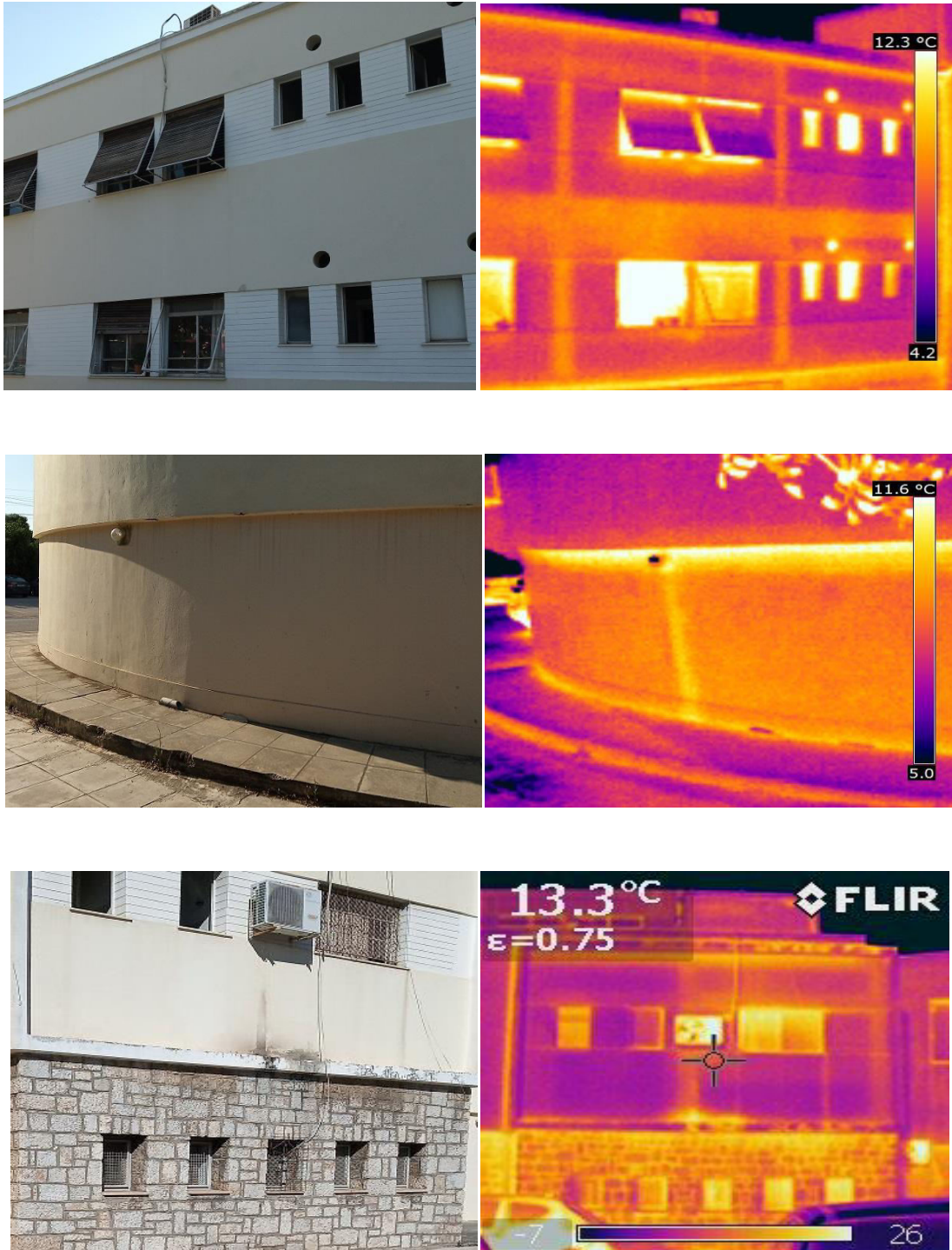
Εικόνα 5.6: Εκροή θερμότητας από τοιχοποιία και υαλοπίνακες
