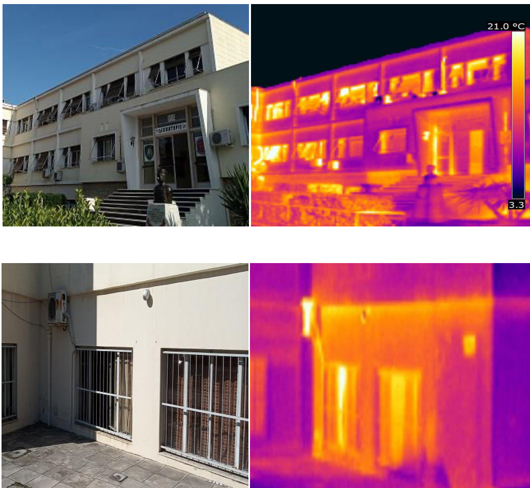
Εικόνα 5.5: Εκροή θερμότητας από τοιχοποιία και υαλοπίνακες
