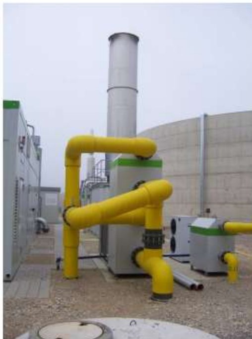
Σχήμα 4-6: Πυρσός βιοαερίου 2
