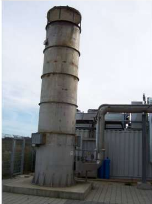
Σχήμα 4-5: Πυρσός βιοαερίου 1
