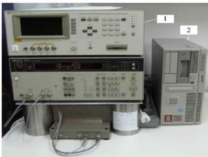
Εικόνα 5.7 Η γέφυρα LCR (1) και ο Η/Υ (2) για τον έλεγχο της
