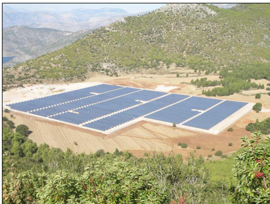
Εικ. 10. Φωτοβολταϊκό πάρκο συνολικής ισχύος 1.50 MW στο Βαθυχώρι Αττικής
