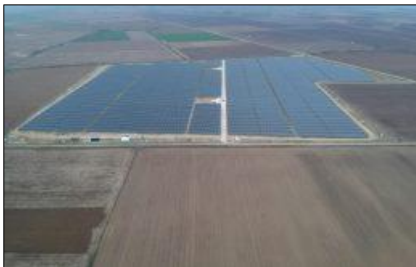
Εικ. 9. Φωτοβολταϊκό πάρκο συνολικής ισχύος 8.99 MW στους Σοφάδες Καρδίτσας
