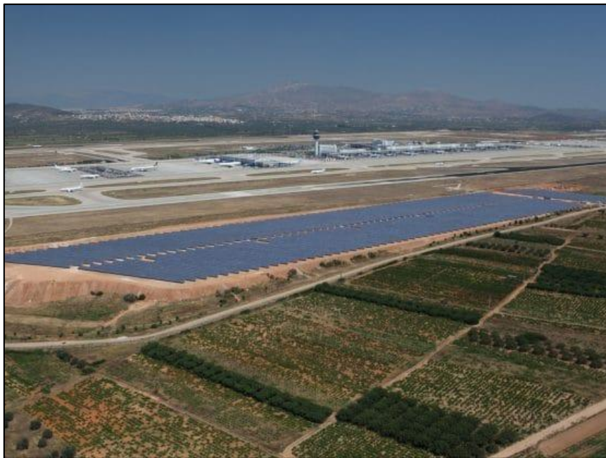
Εικ. 8. Φωτοβολταϊκό πάρκο συνολικής ισχύος 8.05 MW στον Διεθνή Αερολιμένα Αθηνών «Ελευθέριος Βενιζέλος», 2011
