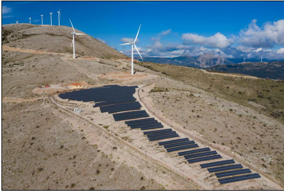
Εικ. 11. Φωτοβολταϊκό πάρκο συνολικής ισχύος 1.05 MW στην Αιτωλοακαρνανία
