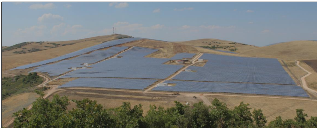
Εικ. 12. Φωτοβολταϊκό πάρκο συνολικής ισχύος 10.30 MW στον Δομοκό
